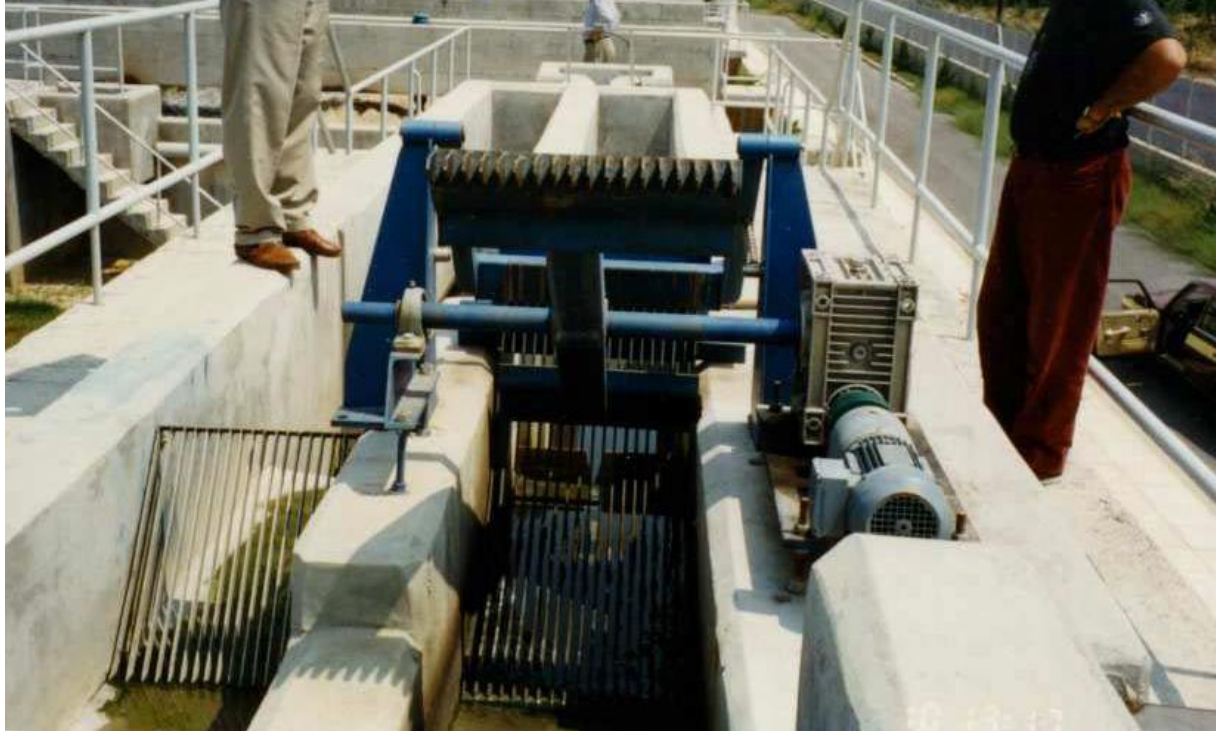
Εικόνα 1. Χειρονακτικά καθαριζόμενη εσχάρα (αριστερά στην εικόνα) και μηχανικά καθαριζόμενη εσχάρα (δεξιά στην εικόνα) 7 .
