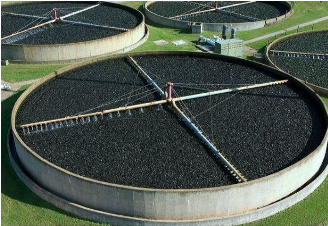
Εικόνα 10. Σταλαγματικά φίλτρα 31 .
