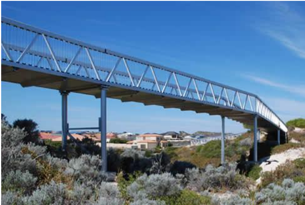
Εικόνα 11: Οικονομικά αποδοτική, πεζοδρομημένη γέφυρα αλουμινίου χαμηλής συντήρησης.
