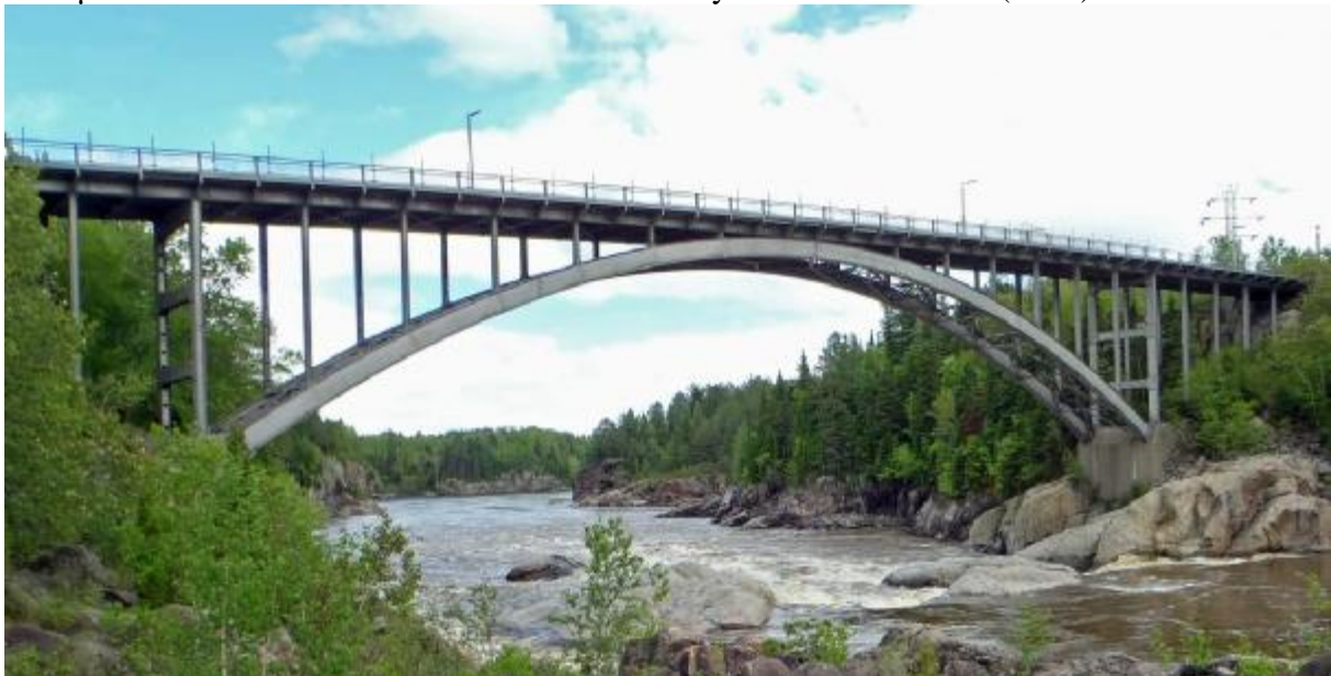
Εικόνα 19:Η πρώτη γέφυρα αλουμινίου για αυτοκίνητα , Arvida , Κεμπέκ , Καναδάς 1949.
