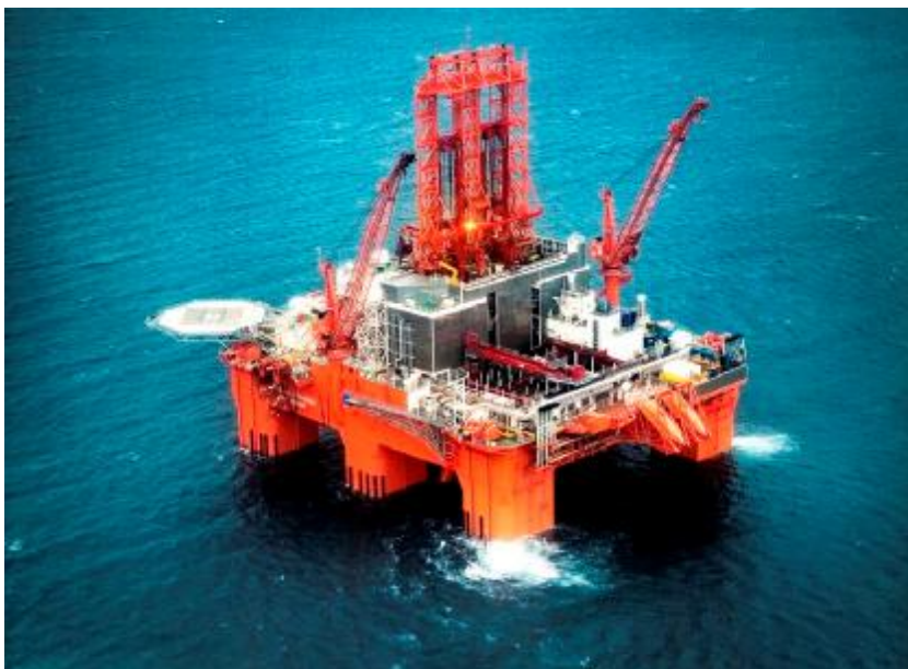
Εικόνα 12: Υπεράκτια κατασκευή αλουμινίου με ελικοδρόμιο.
