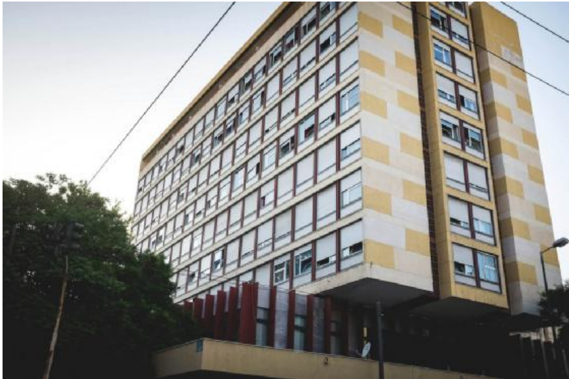
Εικόνα 8 - ΕΞΩΤΕΡΙΚΗ ΟΨΗ ΤΗΣ ΦΕΑ ΣΤΗΝ ΠΑΤΗΣΙΩΝ
