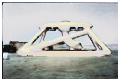
Υποβρύχια κατασκευή απορρόφησης θαλάσσιου νερού
