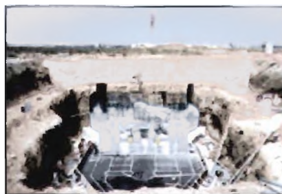
Κατασκευή αντλιοστασίου θαλάσσιου νερού
