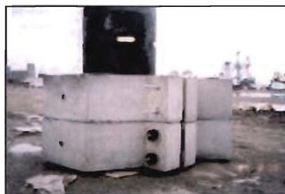
Κατασκευή σωμάτων αγκύρωσης θαλασσίωv αγωγών
