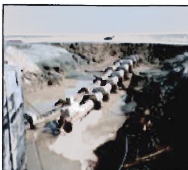
Υποθαλάσσιοι αγωγοί έτοιμοι να συνδεθούν με το αντλιοστάσιο
