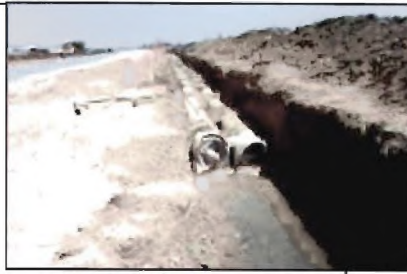
Εγκατάσταση σωλήνων (Fiber Glass) μεταφοράς θαλάσσιου νερού
