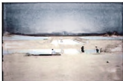
Κατασκευή θεμελίων στην Μονάδα Αφαλάτωσης Λάρνακας
