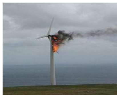
Εικόνα 3.1: Ανεμογεννήτρια χτυπημένη από κεραυνό
