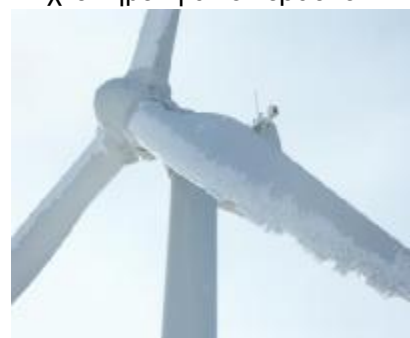
Εικόνα 3.2 : Ανεμογεννήτρια καλυμμένη από πάγο
