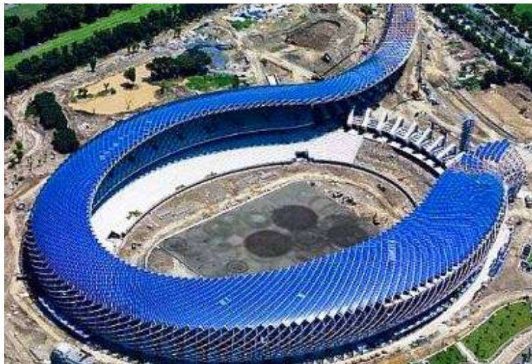
Εικόνα 17 Αθλητικό στάδιο του οποίου το σκέπαστρο αποτελείται από οργανικά Φ/Β στοιχεία
