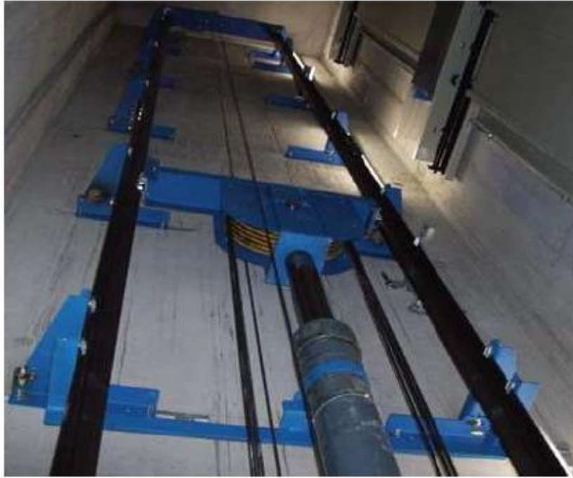
Εικόνα 31: Πλάγια έμμεση ανάρτηση με ένα έμβολο.
