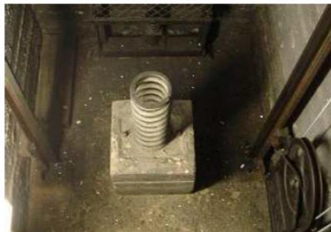
Εικόνα 9: Προσκρουστήρας θαλάμου.
