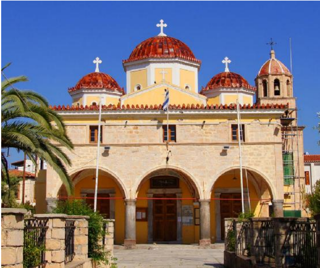
Εικόνα: Άποψη της εκκλησίας της Μητρόπολης στην Αίγινα
