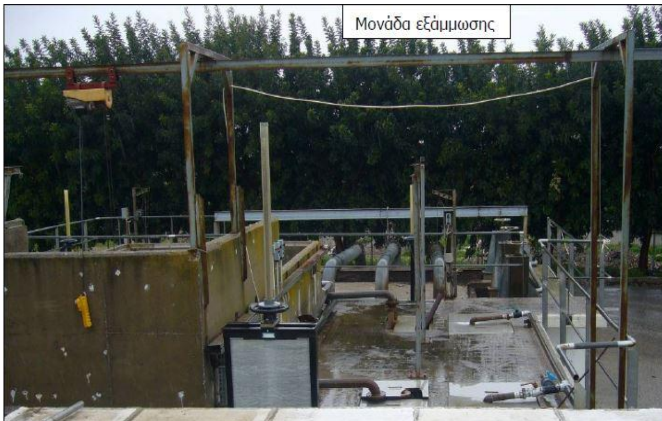
Εικόνα 10: Αμμοσυλλέκτης ΕΕΛ Αιγίου.
