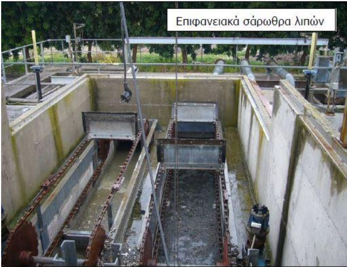
Εικόνα 11: Λιποσυλλέκτης ΕΕΛ Αιγίου.
