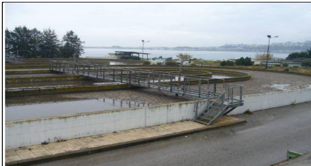
Εικόνα 18. Δεξαμενή αερισμού ΕΕΛ Αιγίου.
