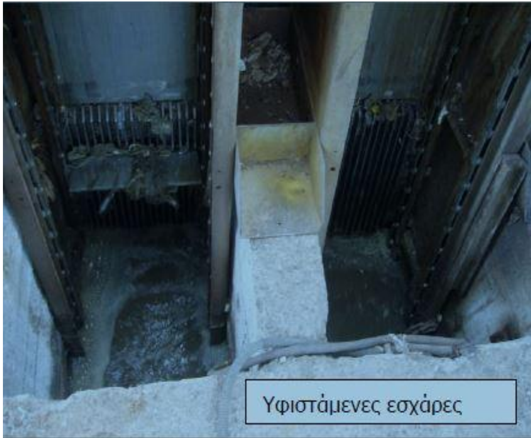
Εικόνα 7: Εσχάρα απλή (χειρονακτικά καθαριζόμενη) ΕΕΛ Αιγίου.
