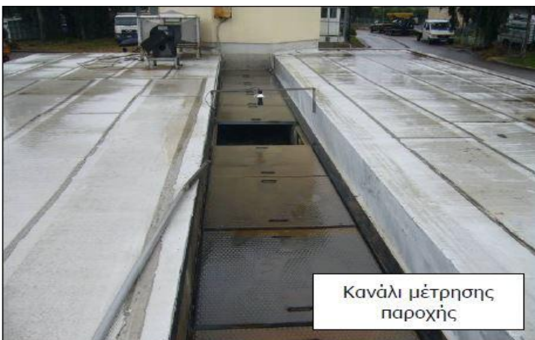
Εικόνα 9: Κανάλι μέτρησης παροχής ΕΕΛ Αιγίου.
