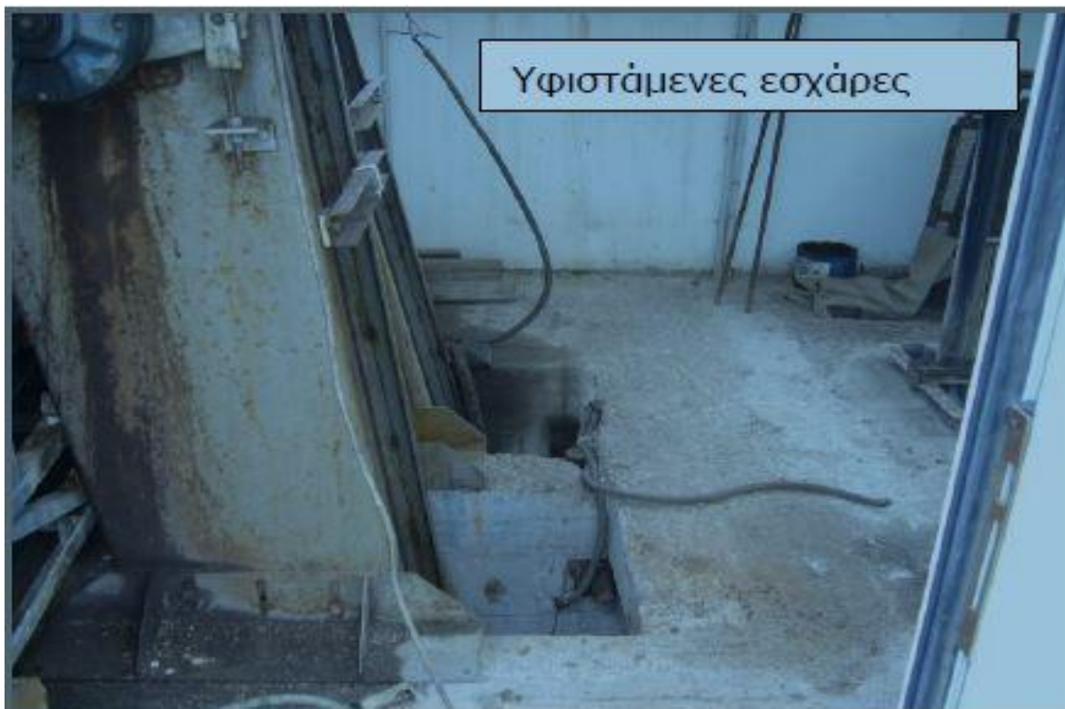
Εικόνα 8: Εσχάρα αυτοκαθαριζόμενη ΕΕΛ Αιγίου.
