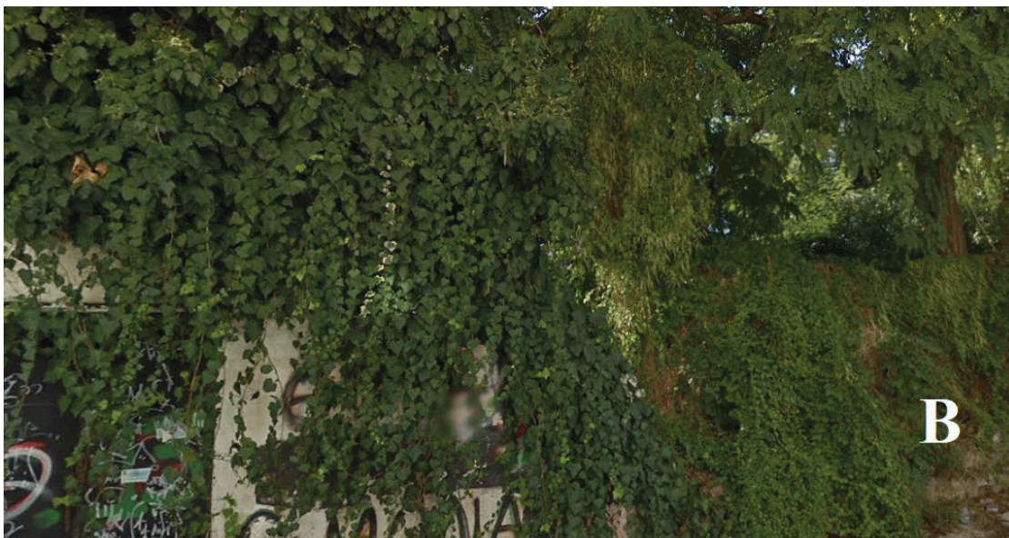
Εικόνα 11. Η σημερινή κατάσταση του κηποθεάτρου εξωτερικά. B:ΝΔ Πλευρά.
