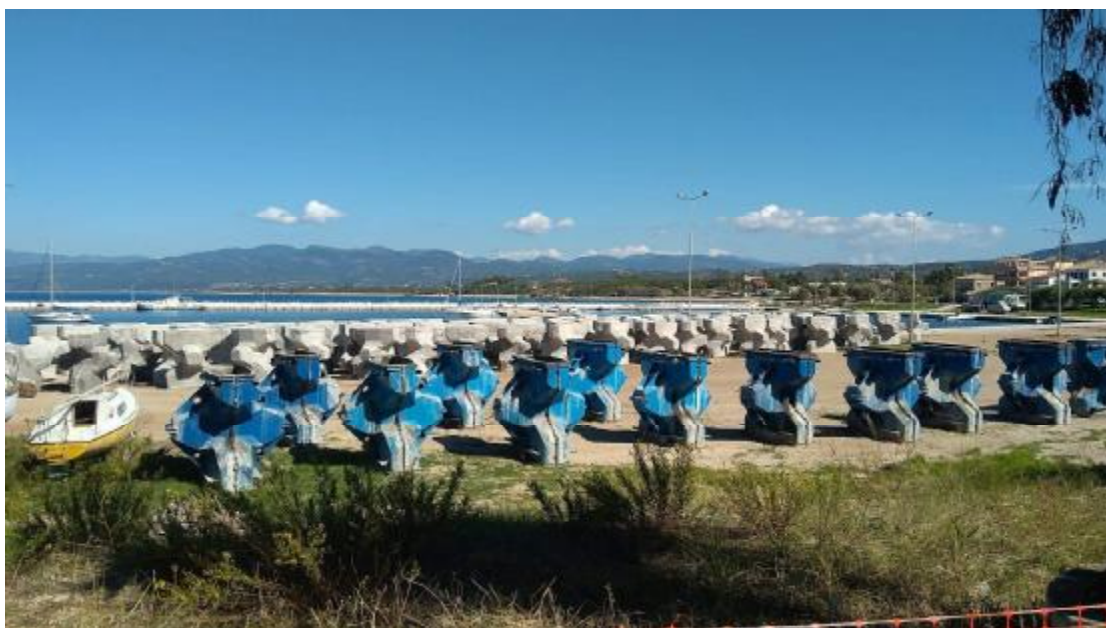
Εικόνα 18: Σε αυτή την φωτογραφία φαίνονται οι τεχνητοί ογκόλιθοι που χρησιμοποιήθηκαν για τη κύρια θωράκιση του κυματοθραύστη. Συγκεκριμένα βλέπουμε ακρόποδα Γαλλικού τύπου, όγκου 9,0 \text{ m}^3 και 21,60 \text{ tn} .
