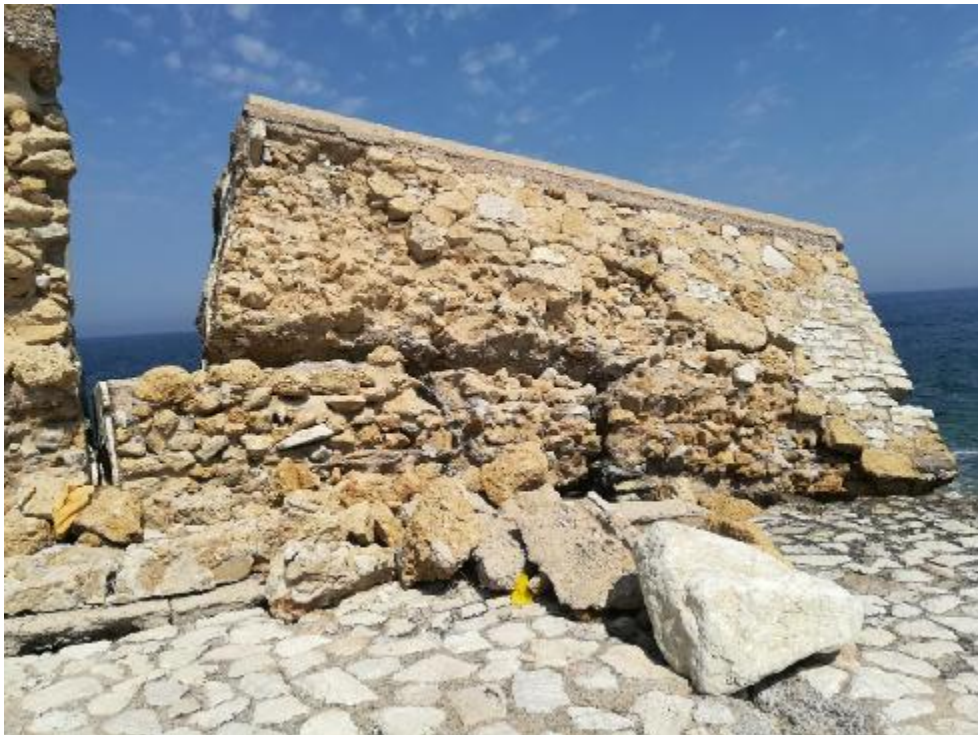
Εικόνα 6: Φωτογραφία στην οποία βλέπουμε καλύτερα ένα κομμάτι του προστατευτικού τοίχους που έχει σπάσει και απομονωθεί από το υπόλοιπο τοίχος.
