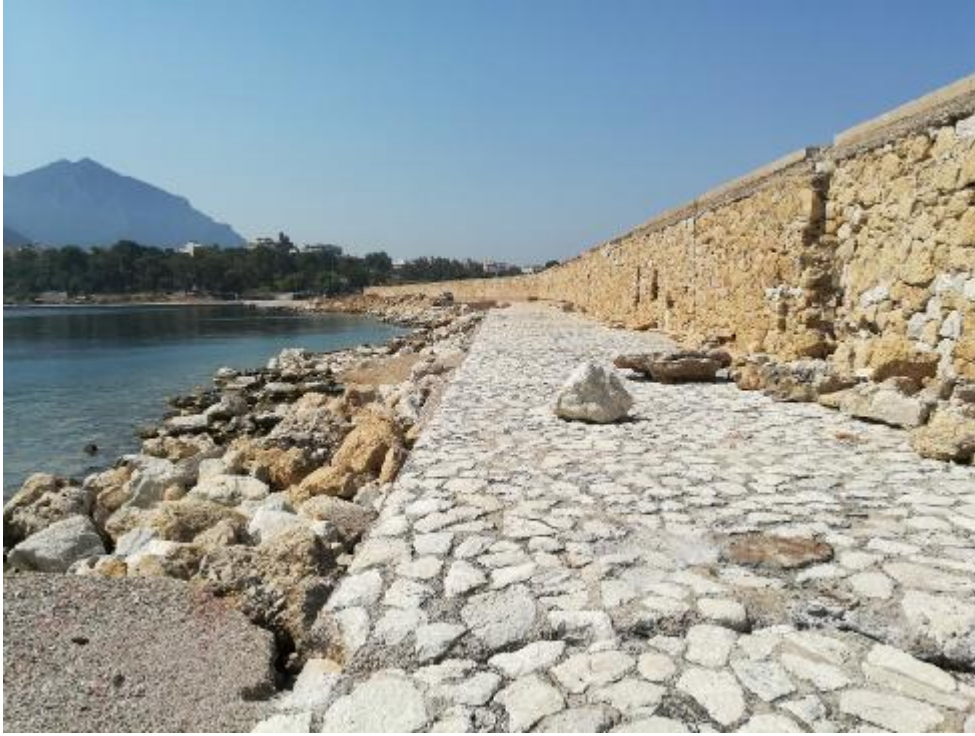
Εικόνα 9: Φωτογραφία προσήνεμου μόλου από το τέλος του προς την αρχή και συγκεκριμένα από τη πλευρά του εσωτερικού του λιμένα.
