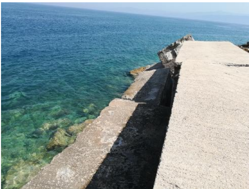
Εικόνα 11: Φωτογραφία προσήνεμου μόλου στο τέλος του από τη πλευρά της θάλασσας, όπου φαίνεται η έλλειψη εξωτερικής θωράκισης.
