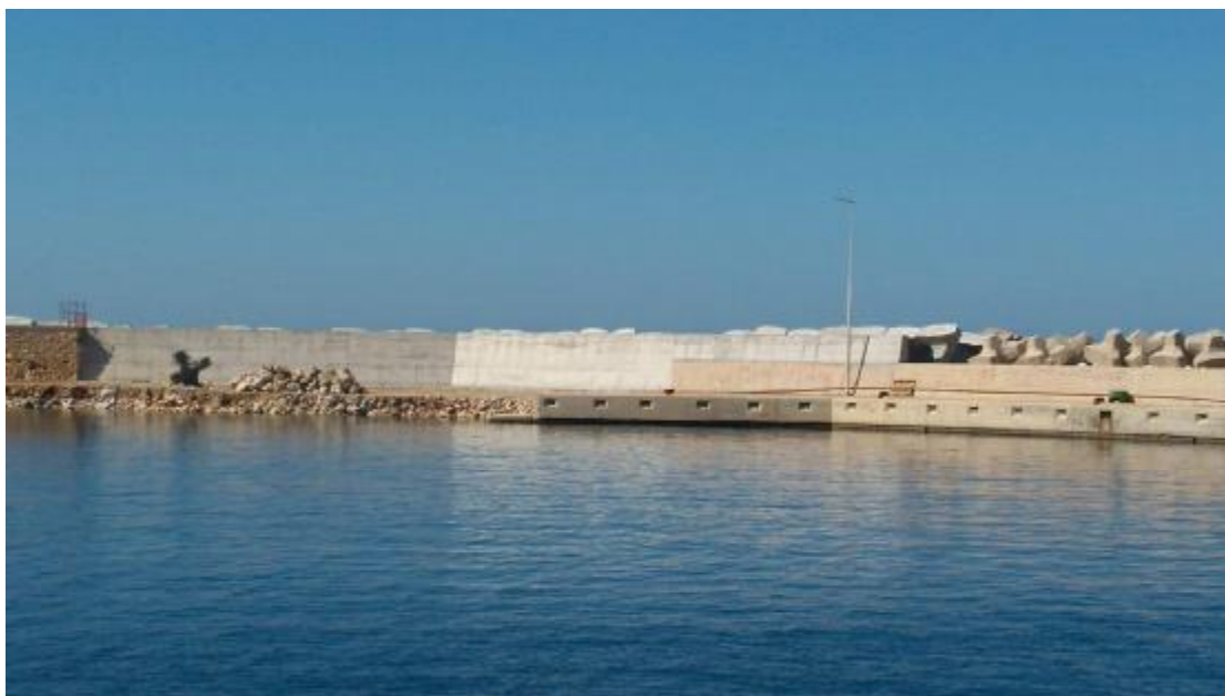
Εικόνα 17: Μια ακόμα πιο κοντινή φωτογραφία του σημείου της επισκευής.
