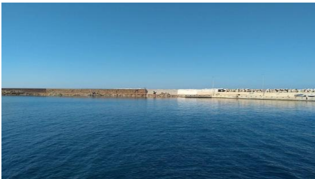
Εικόνα 16: Στην φωτογραφία αυτή βλέπουμε την επισκευή του προστατευτικού τοίχους του προσήνεμου μόλου, στο σημείο της επέκτασής του.
