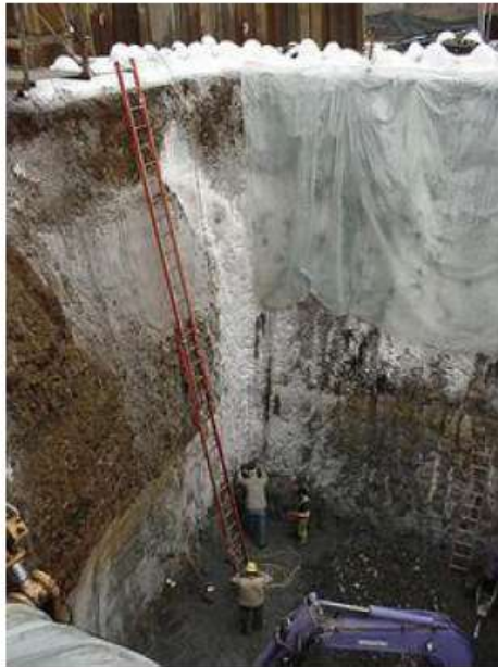
Εικ. 7 Ψύξη εδάφους σε βαθιά εκσκαφή
