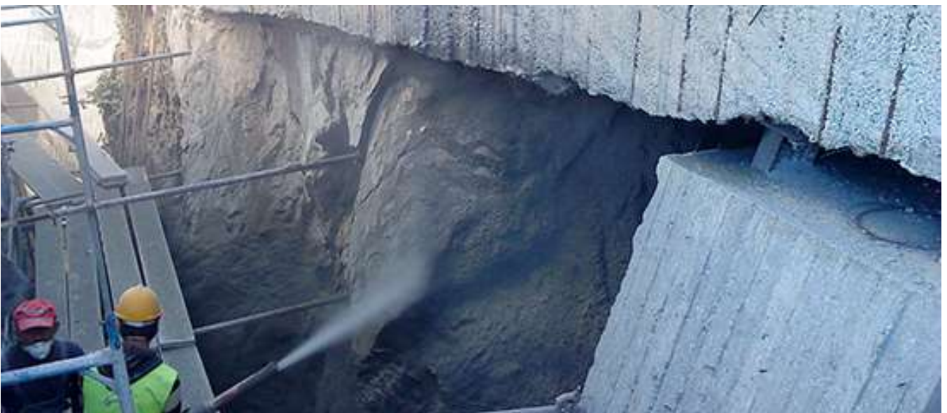
Εικ. 25 Σταθεροποίηση πρανών με εκτοξευόμενο σκυρόδεμα
