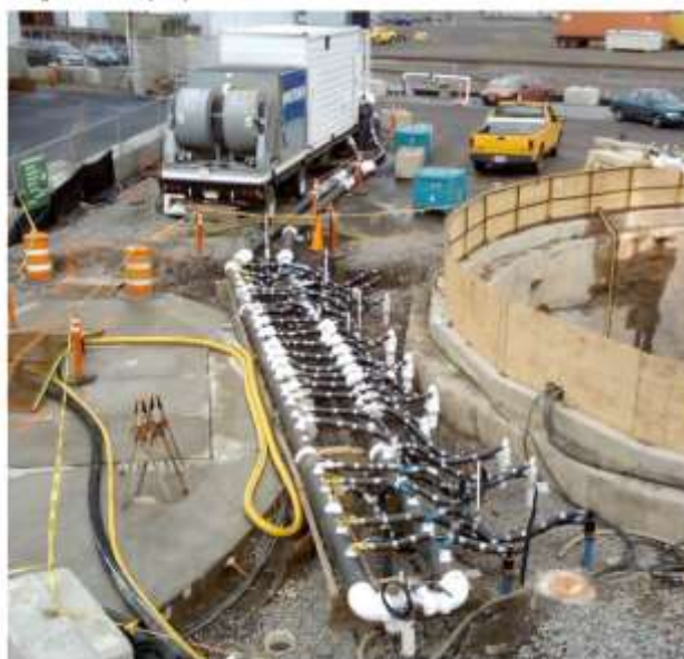
Εικ. 6 Σωλήνες που διαρρέονται από ψυκτικό υγρό
