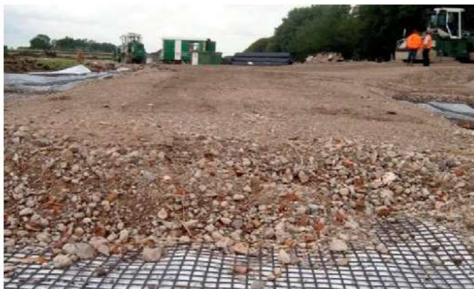
Εικ. 45 Γεωπλέγματα στην επιφάνεια αδύναμου εδάφους
