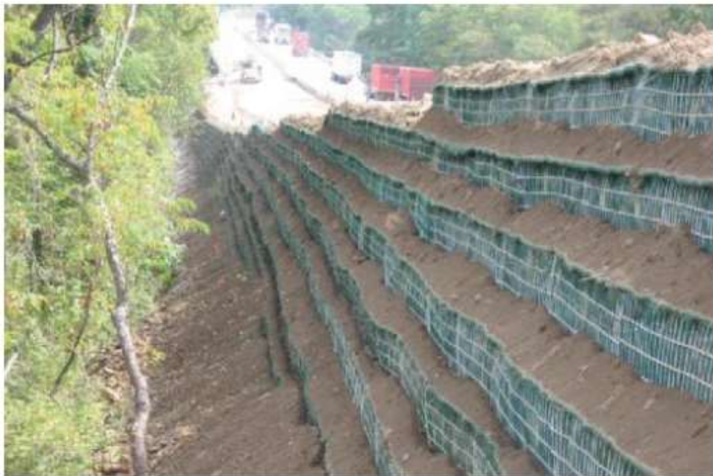
Εικ. 44 Γεώπλεγμα για τη σταθεροποίηση πρανών
