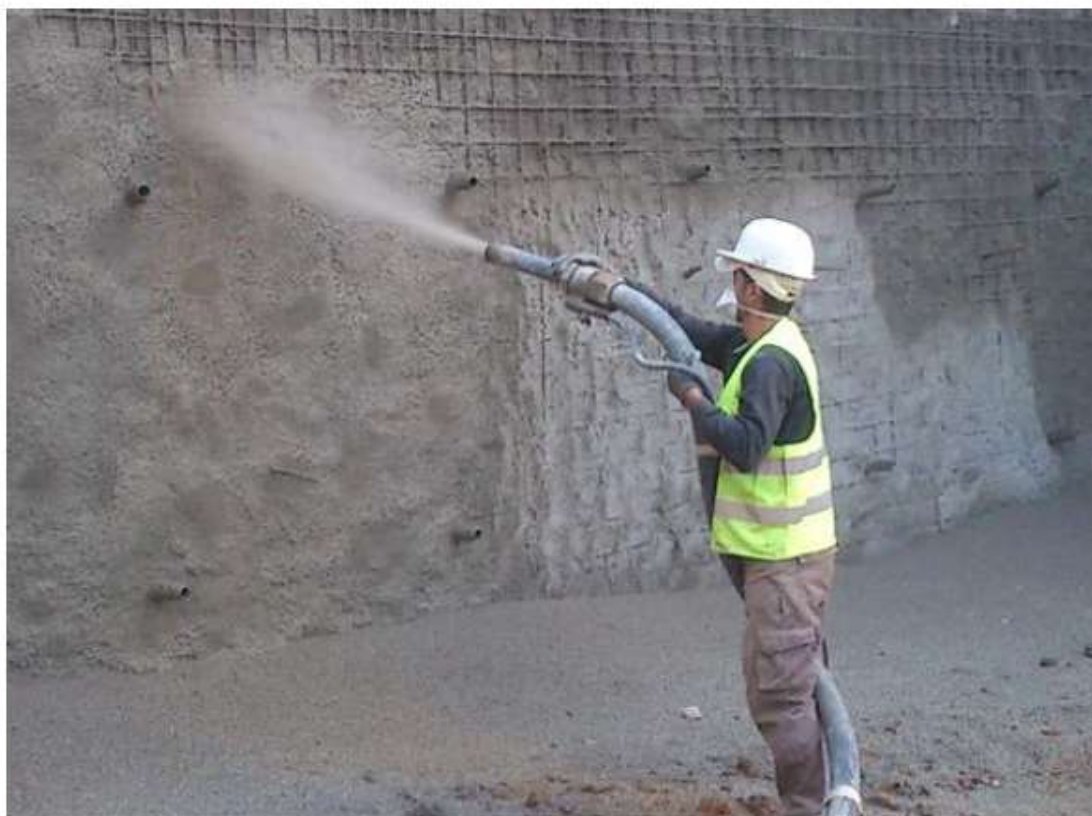
Εικ. 24 Εφαρμογή εκτοξευόμενου σκυροδέματος
