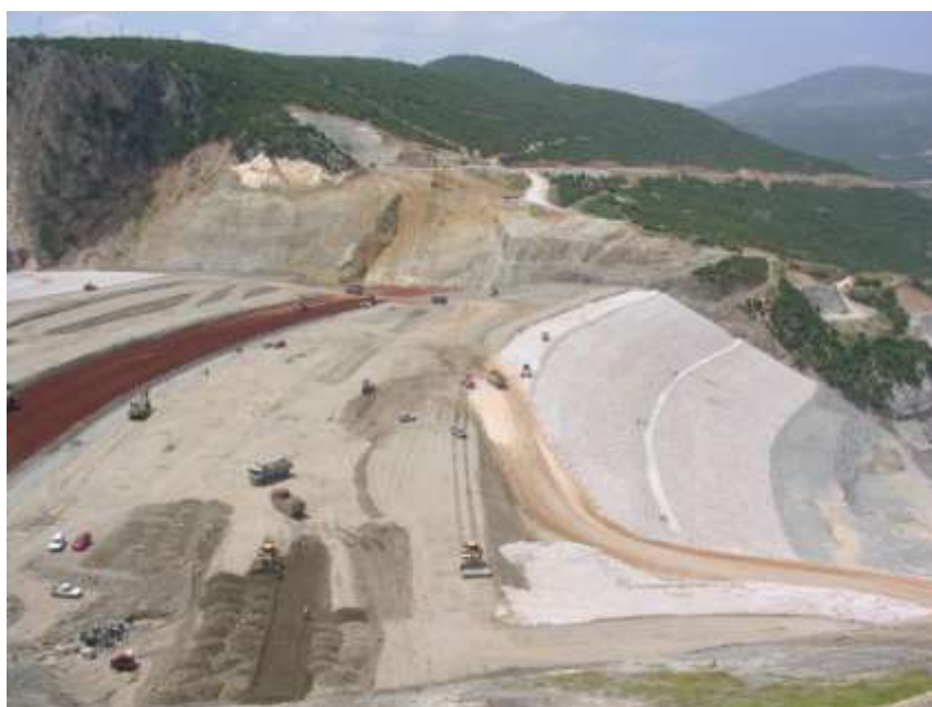
Εικ. 10 Φράγμα Ιλαρίωνα Αλιάκμονα– Επιχωματώσεις
