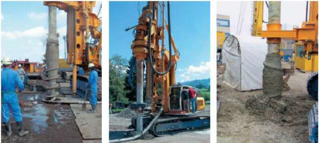
Εικ. 5 Κατασκευή πασσάλων FDP
