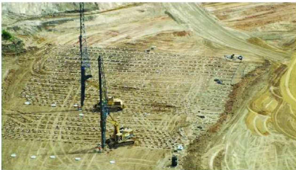
Εικ. 29 Τοποθέτηση γεωσύνθετων στραγγιστηρίων
