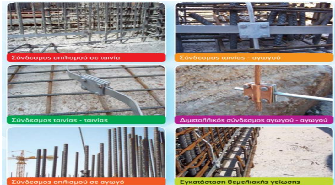
Εικόνα 16: Εγκατάσταση θεμελιακής γείωσης (7)
