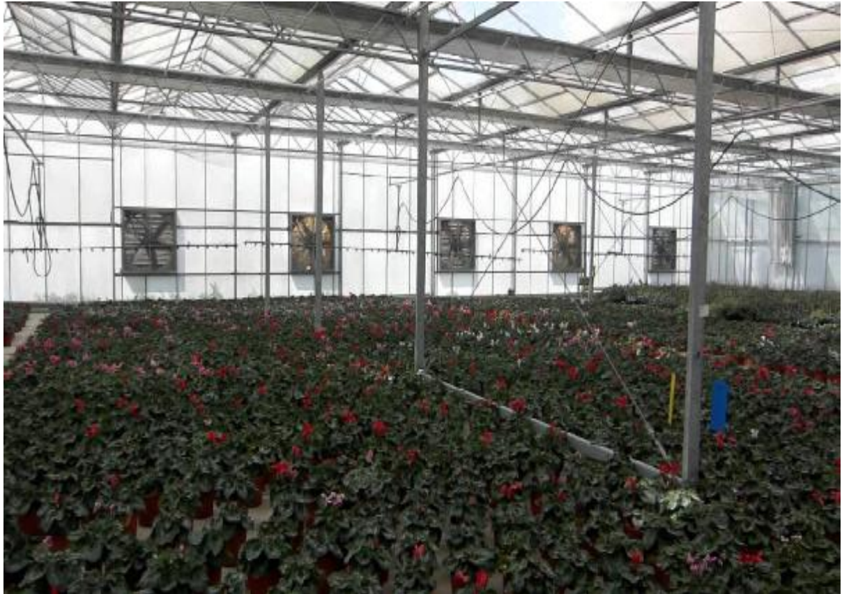
Εικόνα 5: Σύστημα Εξαερισμού σε Θερμοκήπιο
