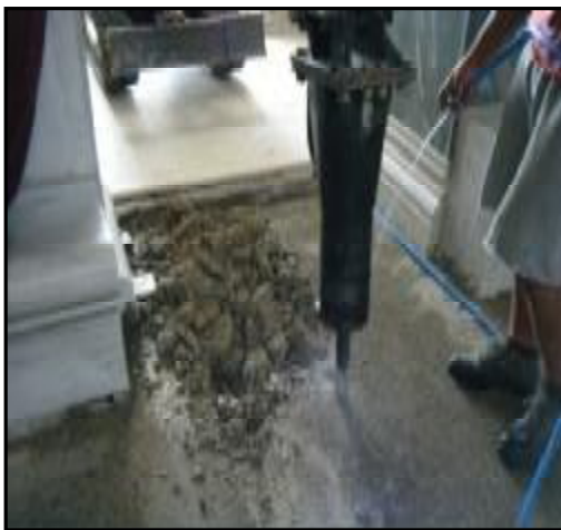
Φ.1 ΕΡΓΑΣΙΕΣ ΓΙΑ ΚΑΤΑΣΚΕΥΗ
