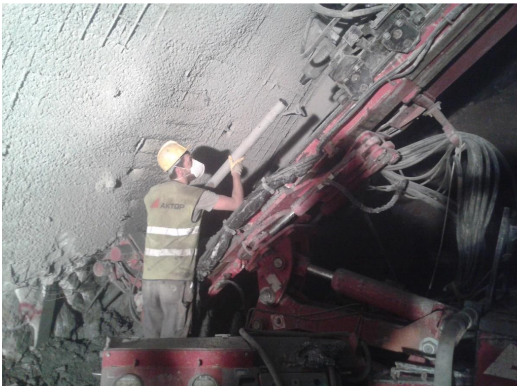
Εικόνα 22:εκτοξευόμενο σκυρόδεμα και fiberglass.
