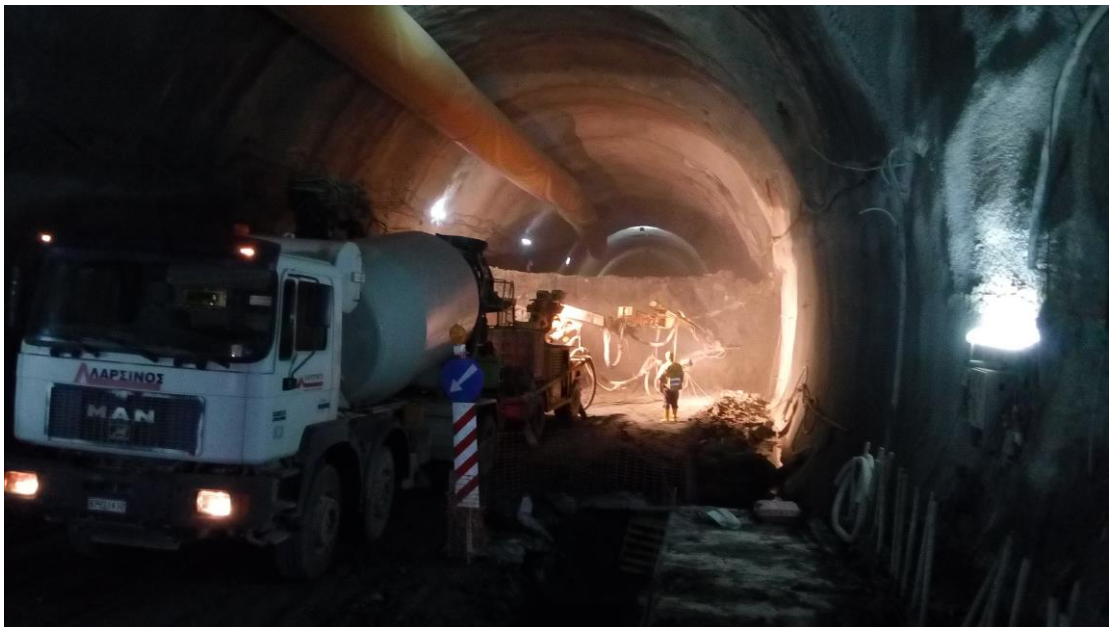
Εικόνα 24: Τοποθέτηση spilling
