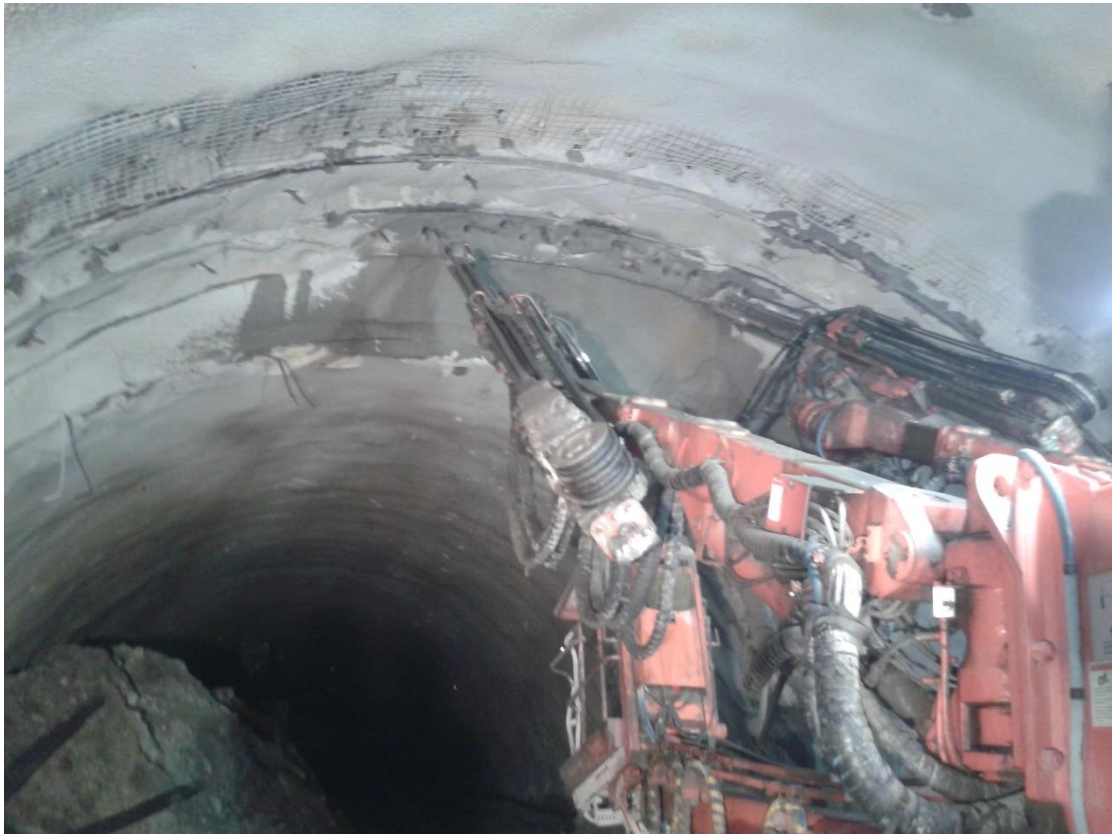
Εικόνα 24: Τοποθέτηση spilling
