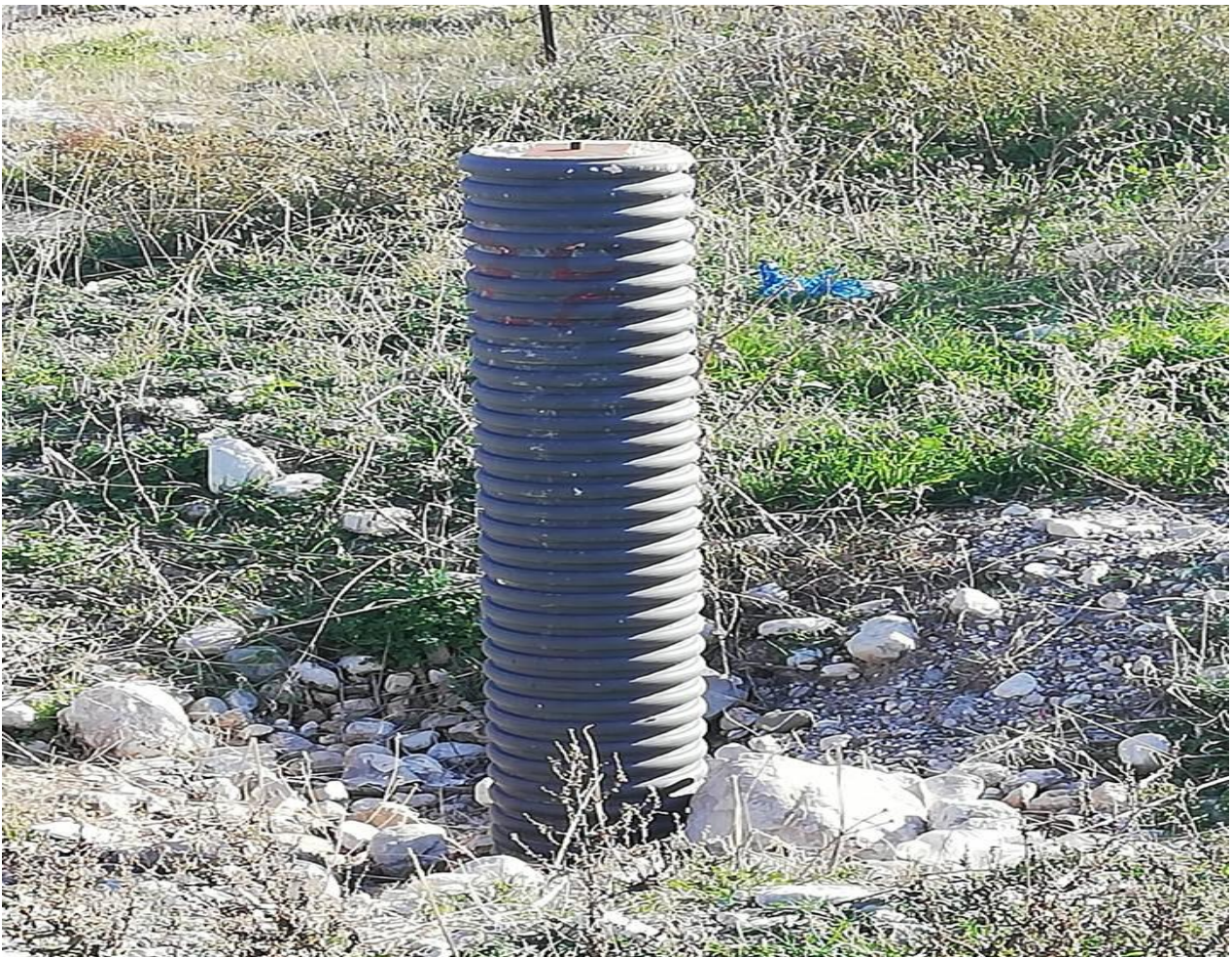
ΦΩΤΟΓΡΑΦΙΑ 4.8 : Σημείο πραγματοποίησης γεώτρησης για τον καθορισμό του είδους του εδάφους.
