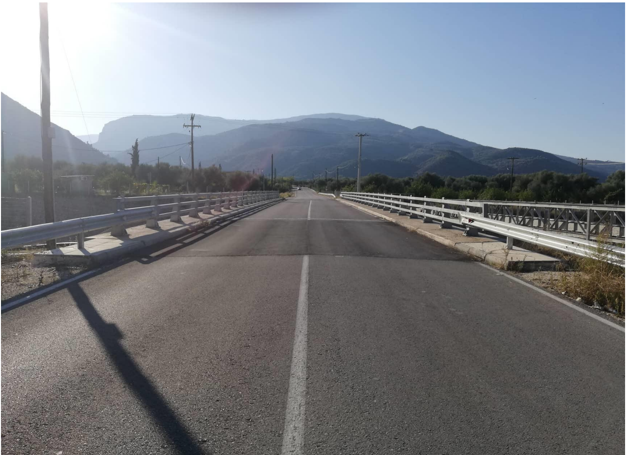
ΦΩΤΟΓΡΑΦΙΑ 4.15 : Διακρίνεται η ανατολική όψη του καταστρώματος της γέφυρας.
