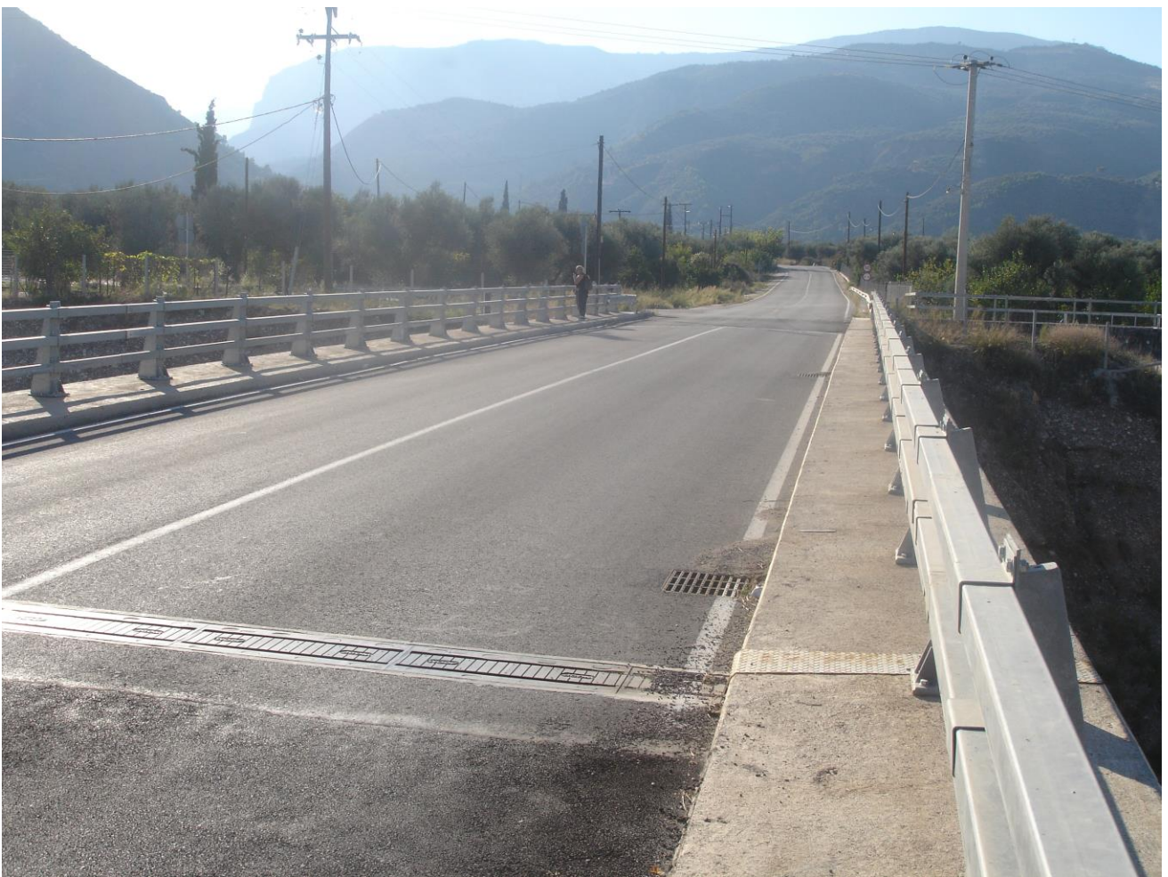
ΦΩΤΟΓΡΑΦΙΑ 4.7 : Γενική άποψη καταστρώματος της παρούσας γέφυρας μετά την ασφαλτόστρωση (ανατολική όψη).
