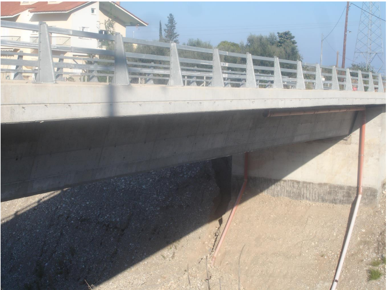
ΦΩΤΟΓΡΑΦΙΑ 4.4 : Φαίνονται οι αγωγοί όμβριων υδάτων νότιας όψης καθώς και τα εφέδρανα εντός των καλουπιών,
