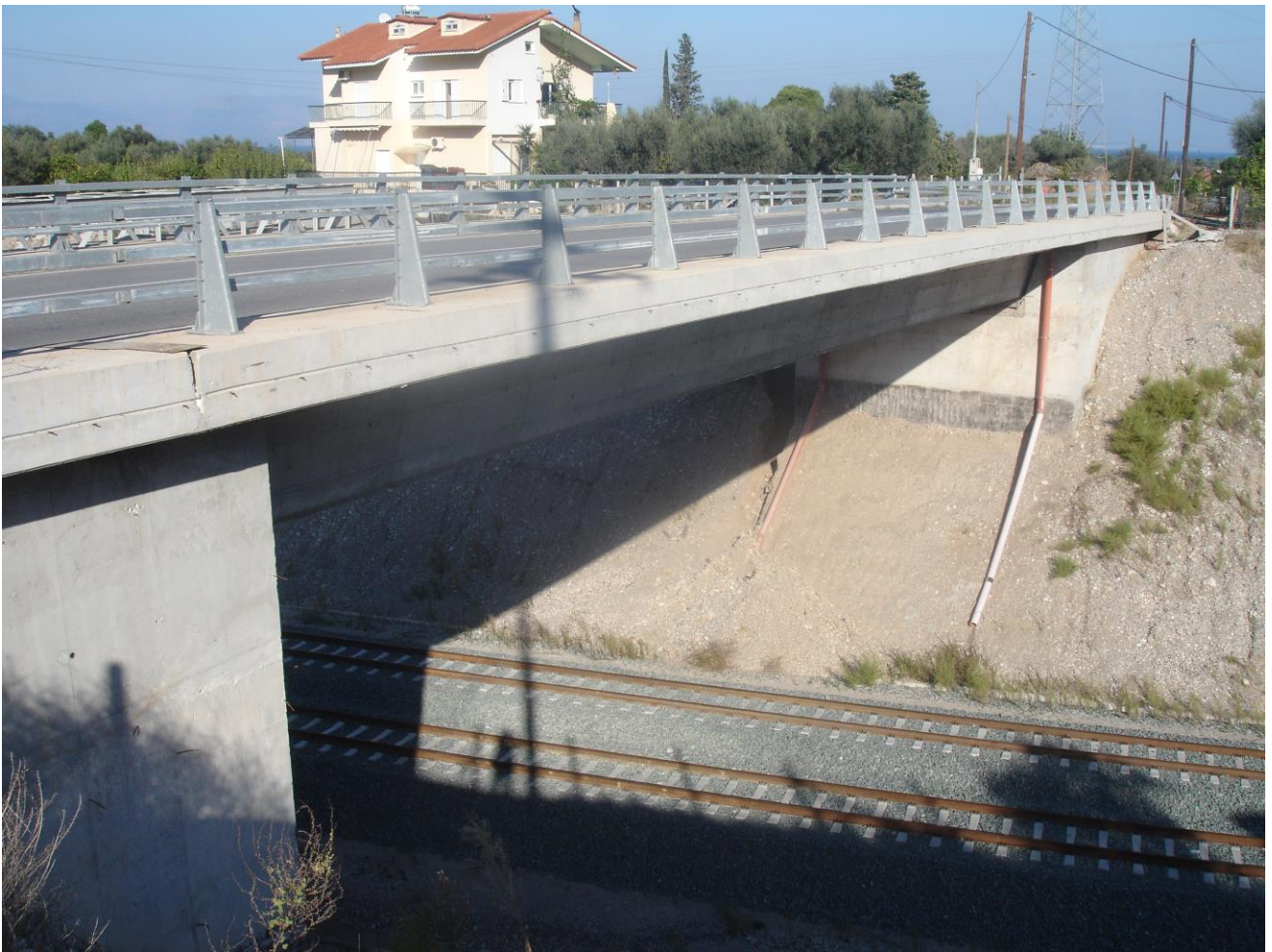
ΦΩΤΟΓΡΑΦΙΑ 4.2 : Νότια όψη γέφυρας μήκους 36 m από προεντεταμένο και οπλισμένο σκυρόδεμα με ελαστομεταλλικά εφέδρανα, στην παράκαμψη Ελαιώνα Δήμου Αιγιαλείας. Διακρίνονται τα ακρόβαθρα και το μεταβατικό επίχωμα από κοκκώδες υλικό και στο βάθος τα εφέδρανα.
