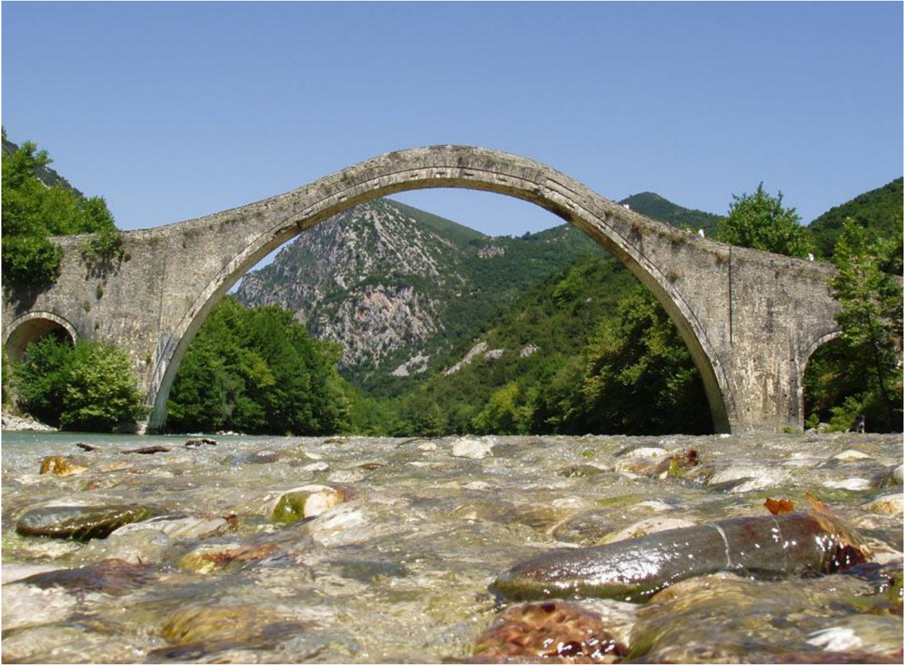
ΕΙΚΟΝΑ 1.3: Γέφυρα της Πλάκας στην Ήπειρο.
