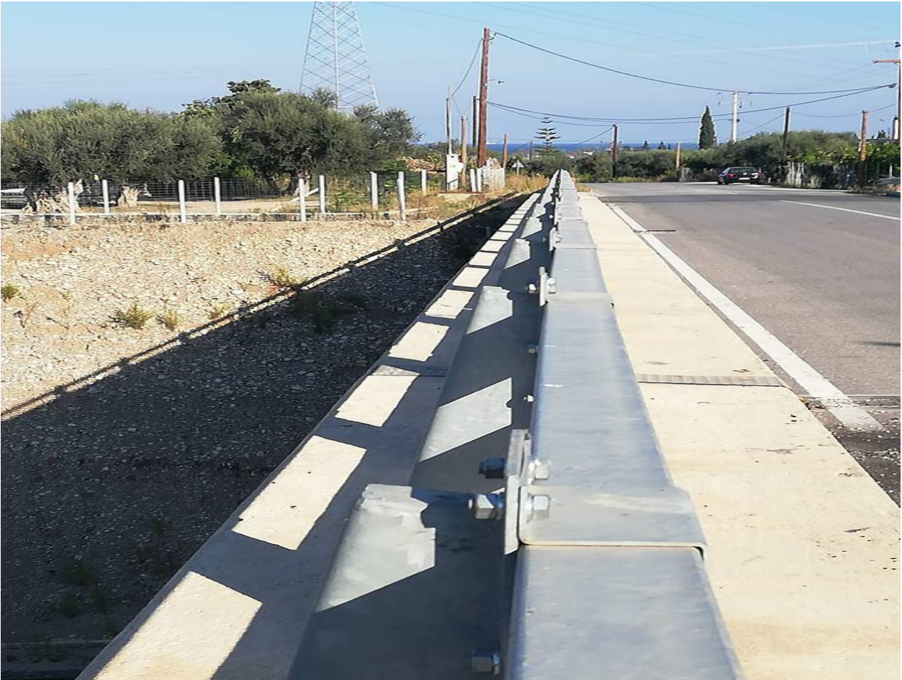
ΦΩΤΟΓΡΑΦΙΑ 4.11 : Διακρίνεται το προστατευτικό κιγκλίδωμα του δρόμου του καταστρώματος .
