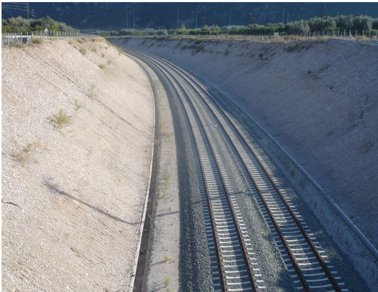
ΦΩΤΟΓΡΑΦΙΑ 4.10 : Διακρίνεται το μεταβατικό επίχωμα από κοκκώδες υλικό και το νότιο τμήμα της σιδηροδρομικής γραμμής.
