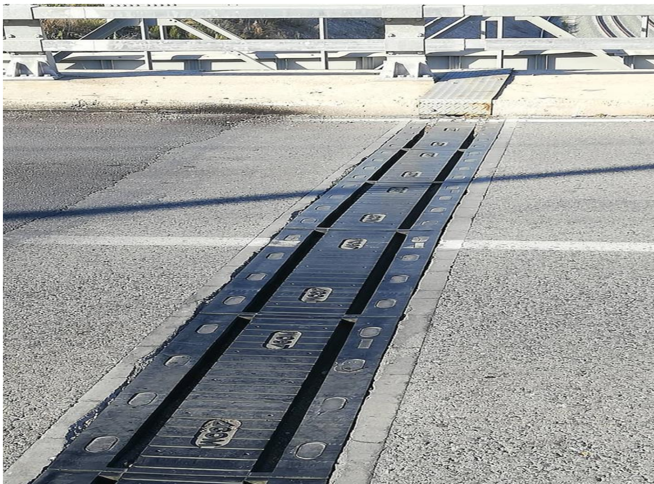
ΦΩΤΟΓΡΑΦΙΑ 4.5 : Μεταλλικό κάλυμμα του διαχωριστικού αρμού τύπου ALGAFLEX T120.
