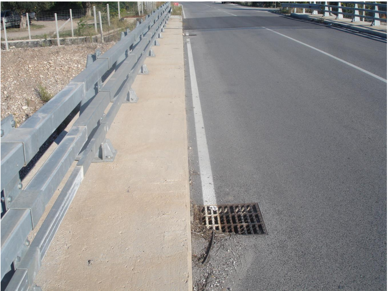
ΦΩΤΟΓΡΑΦΙΑ 4.6 : Θέση αγωγού παροχέτευσης όμβριων υδάτων.
