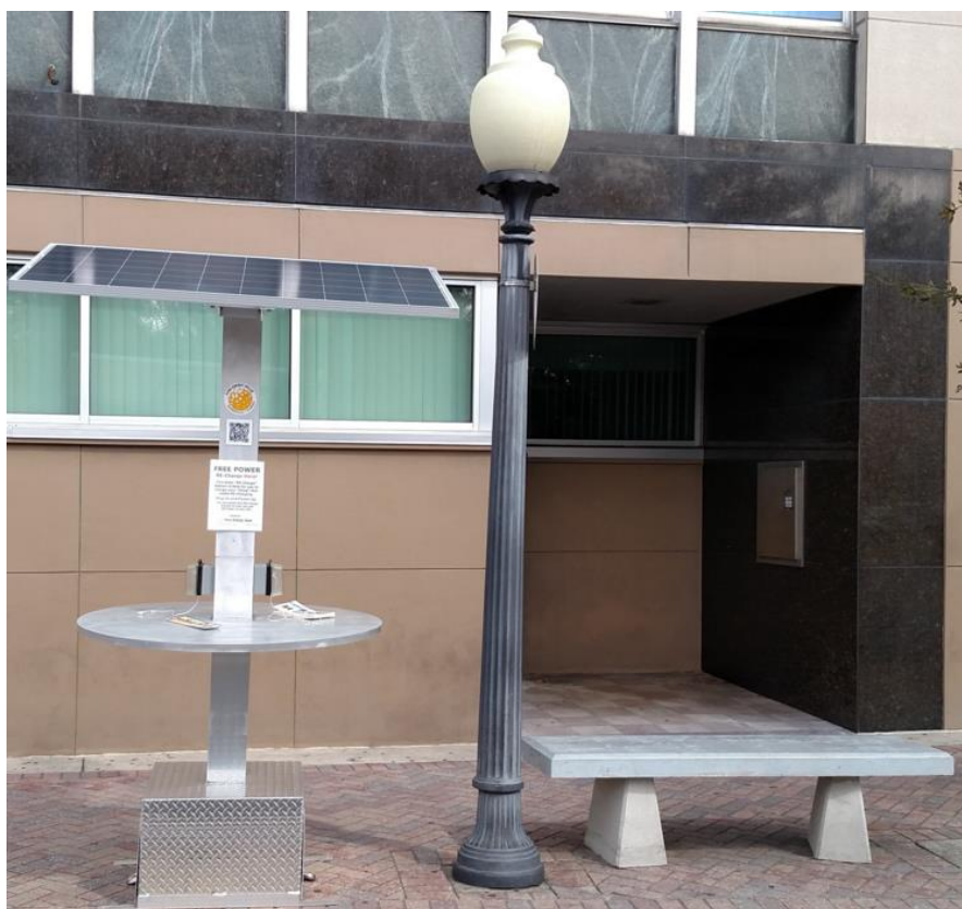
Εικόνα 42:Ηλιακό κίосκι με πρίζες φόρτισης
