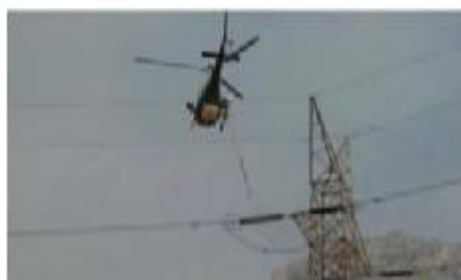
Εικόνα 42: Πλύσιμο μονωτήρων
