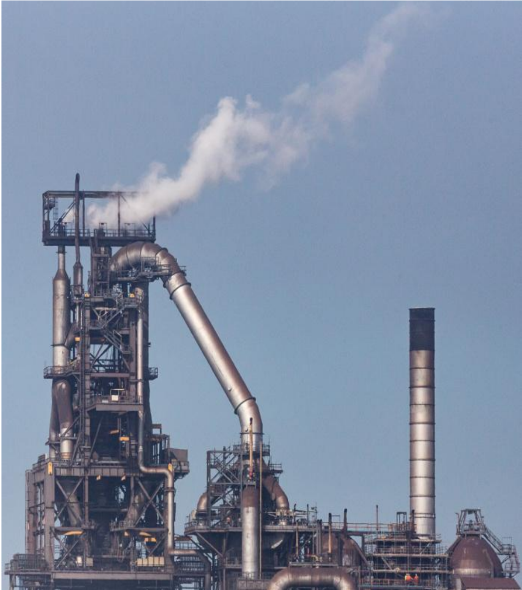
Εικόνα 2.3: Εγκατάσταση υψικαμίνου [ https://theperimeteruk.files ]
