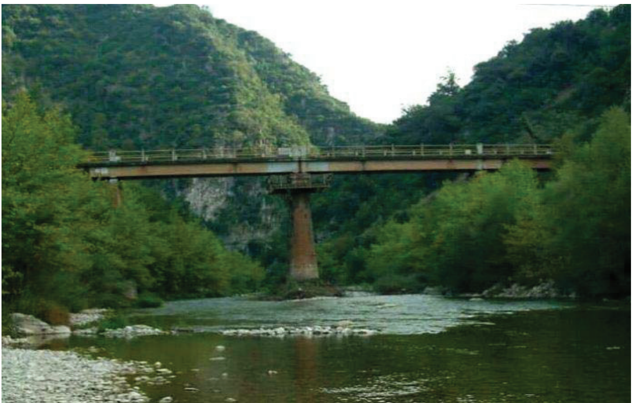
Εικόνα 6 Πανοραμική Άποψη Γέφυρας στη θέση Πόρος Ρηγανίου
