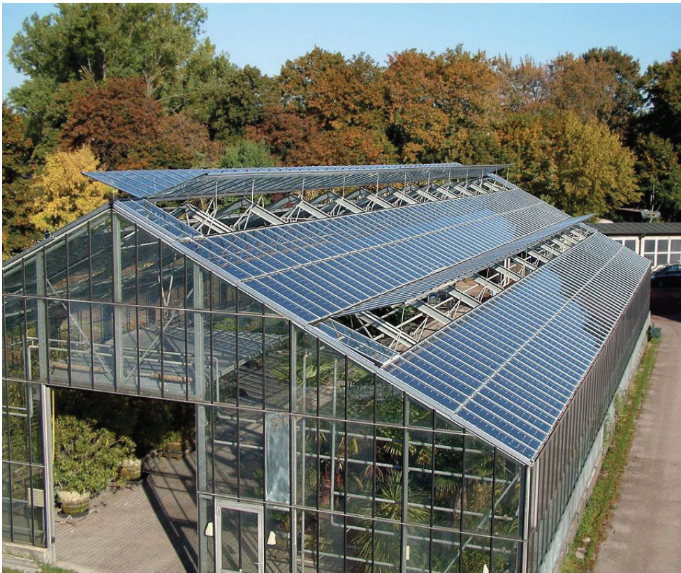
Εικόνα 3.1: Εγκατεστημένα φωτοβολταϊκά σε στέγη θερμοκηπίου, Σάντα Κρούζ, ΗΠΑ[56]
