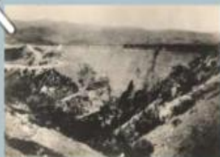
Φράγμα πριν την καταστροφή
