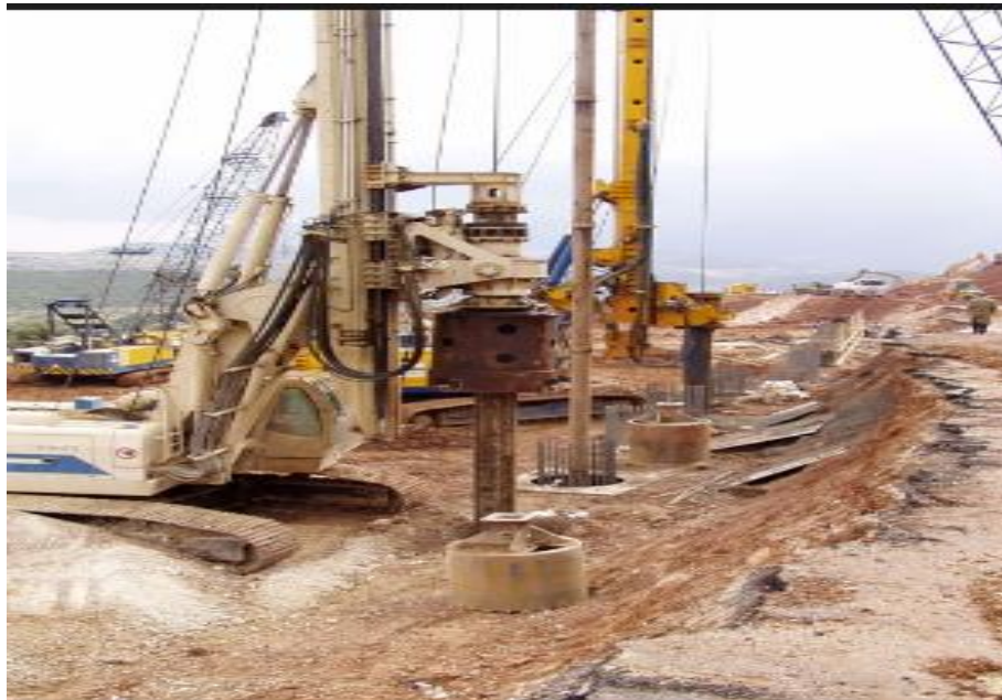
Σχήμα 3.6 Διαδικασία εγκατάστασης έγχυτων πασσάλων
