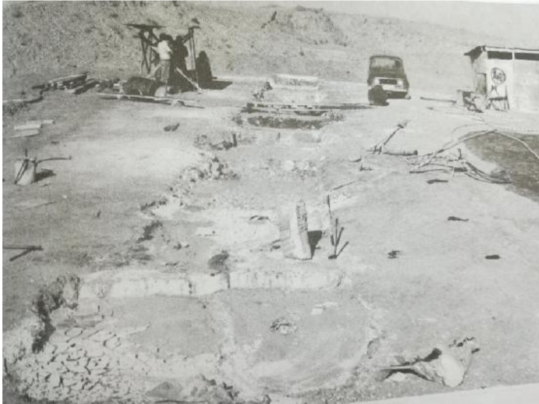
Σχήμα 3.4 Κατασκευή διαφραγματικού τοίχου στο φράγμα του Στράτου
