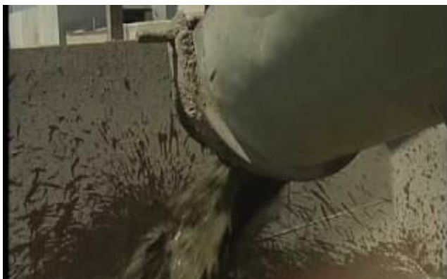
Εικόνα_6: Έτοιμο σκυρόδεμα.
