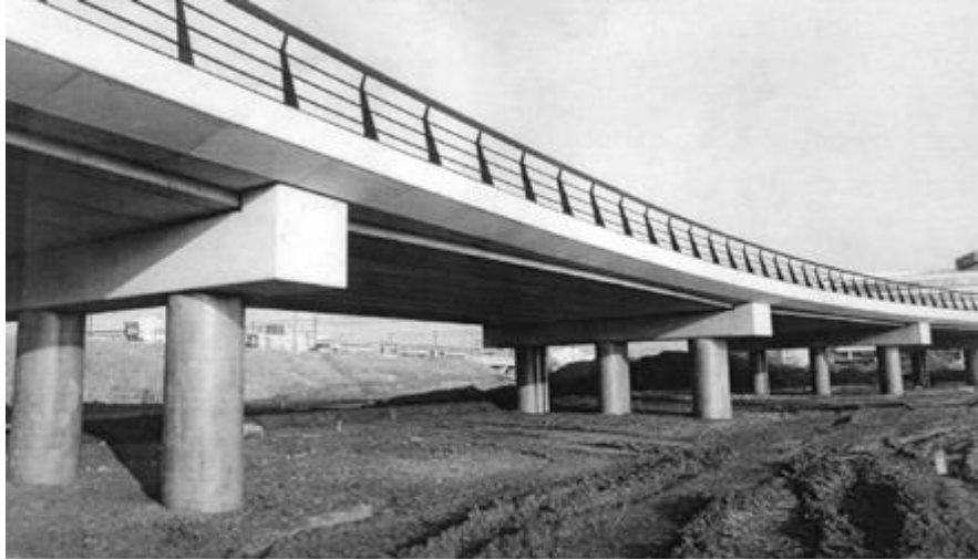
Εικ. 6.6: Προκατασκευασμένη γέφυρα με προφίλ καμπύλου άκρου. (Πηγή: “PRECAST CONCRETE BRIDGES”, state-of-art-report, fib ceb-fip (bulletin 29))
