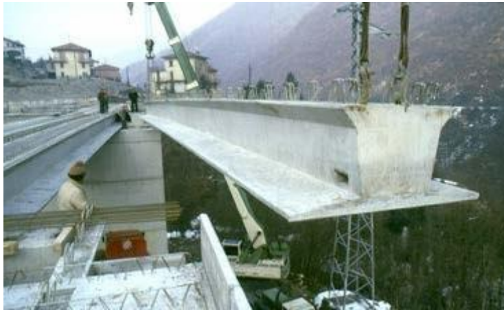
Εικ. 4.16: Παράδειγμα δοκών κιβωτιοειδούς διατομής με αναχίλωση κάτω μέρους για γέφυρες με κλειστό υποκατάστρωμα. (Πηγή: “PRECAST CONCRETE BRIDGES”, state-of-art-report, fib ceb-fip (bulletin 29))
