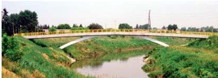
Εικ. 4.33 και 4.34: Προκατασκευασμένες τοξωτές γέφυρες. (Πηγή: “ PRECAST CONCRETE BRIDGES ”, state-of-art-report, fib ceb-fip (bulletin 29))
