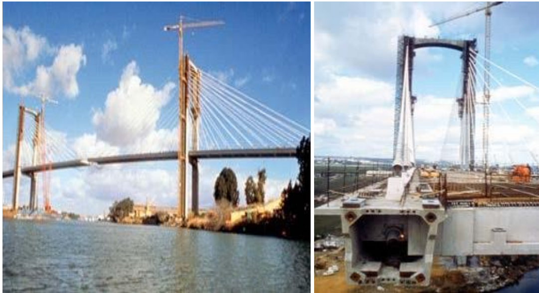
Εικ. 4.32: Προκατασκευασμένη καλωδιωτή γέφυρα. (Πηγή: “PRECAST CONCRETE BRIDGES”, state-of-art-report, fib ceb-fip (bulletin 29))
