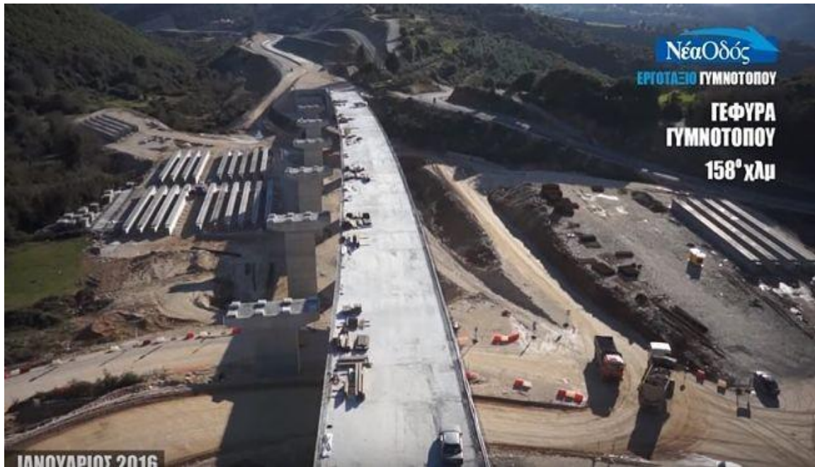
Εικ. 7.1: Ολοκλήρωση εργασιών κατασκευής πλάκας καταστρώματος στον πρώτο κλάδο – Διακρίνονται οι προκατασκευασμένες δοκοί που θα τοποθετηθούν στο δεύτερο. (Πηγή: www.neaodos.gr )
