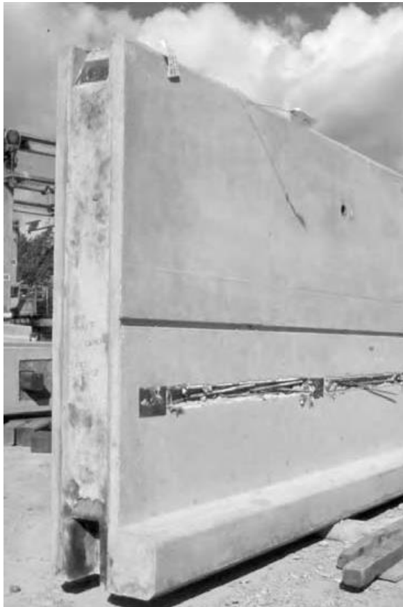
Εικ.2.17: Ακραία δοκός παχέως τυμπάνου προς υποστήριξη πλάκας διατομής διπλού T.
