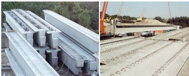
Εικ. 4.14: Δοκοί τέλειου T στον χώρο προσωρινής αποθήκευσης και κατά την ανύψωσή τους, πριν από τη συναρμογή τους με το κατάστρωμα της γέφυρας. (Πηγή: “PRECAST CONCRETE BRIDGES”, state-of-art-report, fib ceb-fip (bulletin 29))
