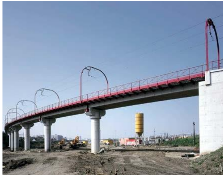
Εικ. 6.5: Σιδηροδρομική κοιλαδογέφυρα με προκατασκευασμένα προφορτισμένα εσωτερικά στοιχεία. Τα βάθρα και οι κεφαλοδοκοί προκατασκευάζονται από βιομηχανικό μπετό. (Πηγή: “PRECAST CONCRETE BRIDGES”, state-of-art-report, fib ceb-fip (bulletin 29))
