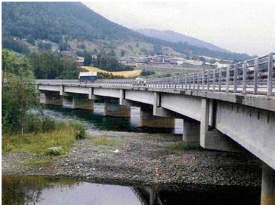
Εικ. 4.11: Προκατασκευασμένη γέφυρα πάνω από υδάτινο κώλυμα με πολυγωνικό κατά μήκος προφίλ διατομής. (Πηγή: “PRECAST CONCRETE BRIDGES”, state-of-art-report, fib ceb-fip (bulletin 29))
