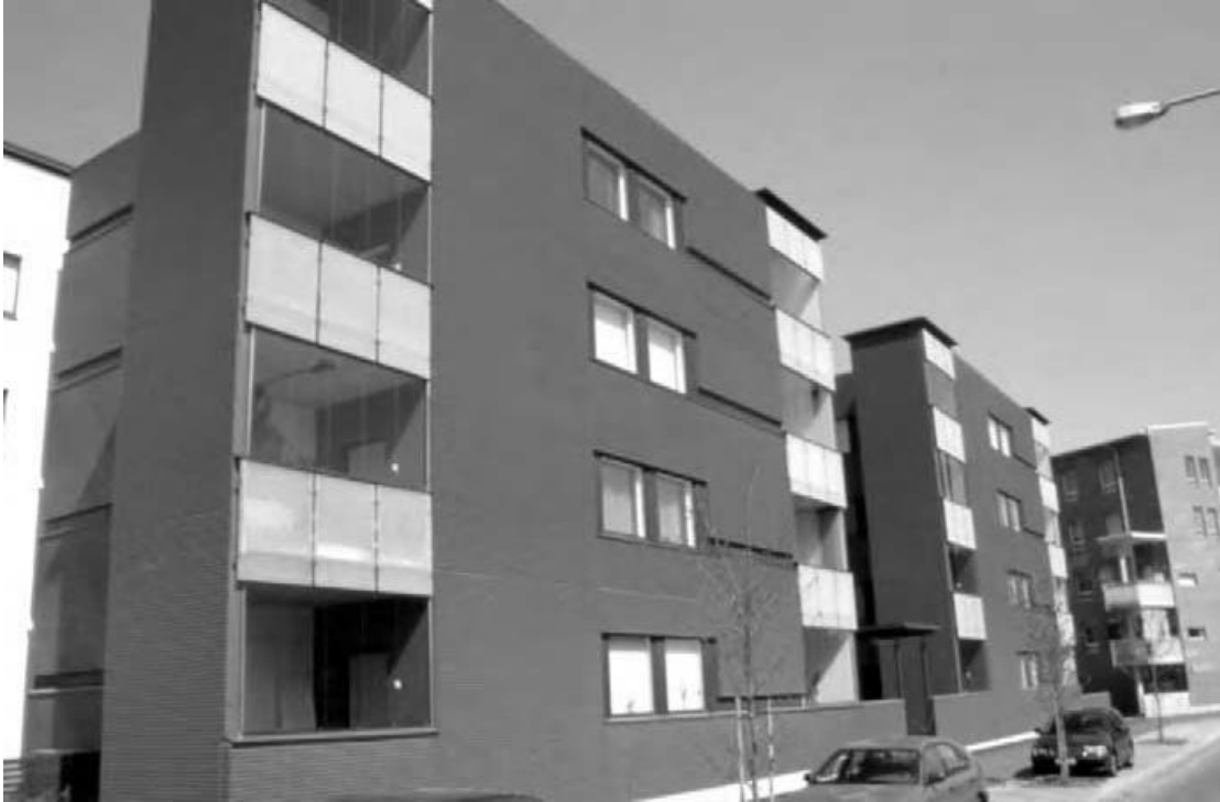
Εικ. 2.4: Εξωτερική πρόσοψη κτιρίου με φέροντα τοιχώματα. (Πηγή: “PRECAST CONCRETE STRUCTURES”, Kim S. Eliot)
