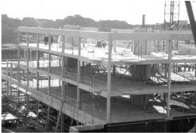
Εικ. 2.1: Προκατασκευασμένη πλαισιακή κατασκευή που παρουσιάζει μεγάλα ανεμπόδιστα κενά προς όφελος κατασκευής, εργατών αλλά και πελατών. (Πηγή: “PRECAST CONCRETE STRUCTURES”, Kim S. Eliot)
