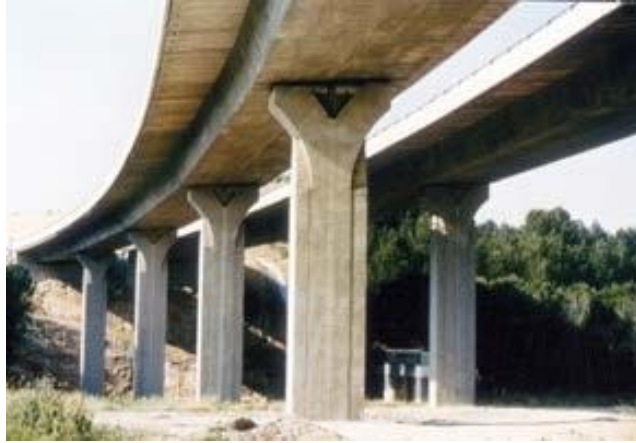
Εικ. 5.14: Ολόσωμη προκατασκευασμένη γέφυρα κιβωτιοειδών δοκών με προκατασκευασμένα βάθρα. (Πηγή: “PRECAST CONCRETE BRIDGES”, state-of-art-report, fib ceb-fip (bulletin 29))
