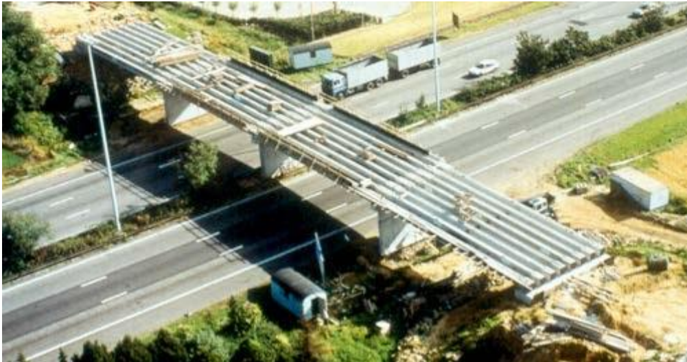
Εικ. 4.9: Γέφυρα με ζυγώματα κατά την κατασκευή της πάνω από αυτοκινητόδρομο χωρίς παρεμπόδιση της κυκλοφορίας. (Πηγή: “PRECAST CONCRETE BRIDGES”, state-of-art-report, fib ceb-fip (bulletin 29))
