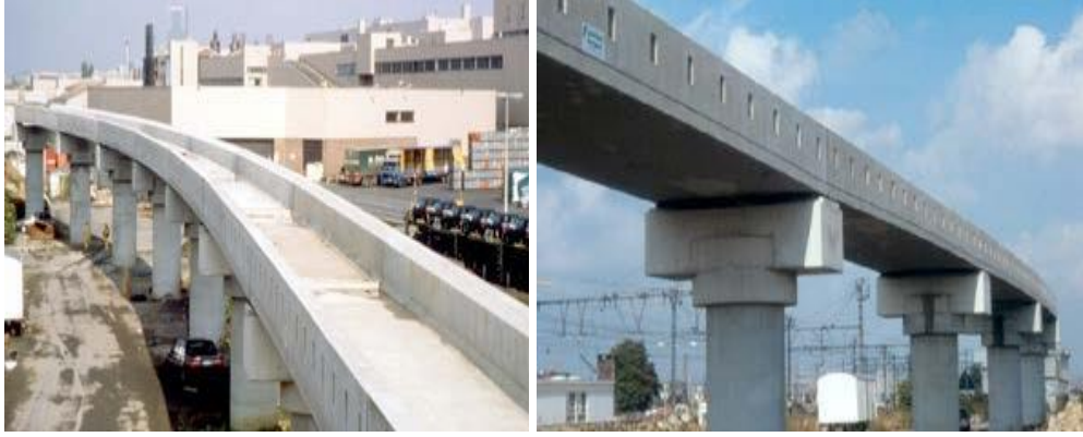
Εικ. 4.29: Γέφυρες σκαφοειδούς μορφής για σιδηροδρομική γραμμή. (Πηγή: “PRECAST CONCRETE BRIDGES”, state-of-art-report, fib ceb-fip (bulletin 29))
