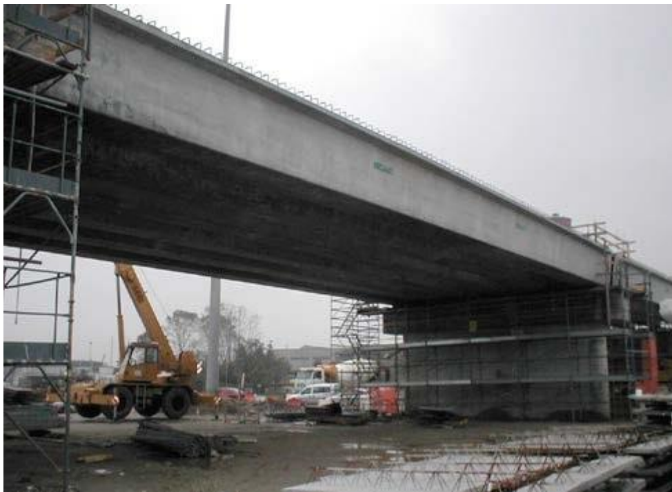
Εικ. 6.7: Κοιλαδογέφυρα από βιομηχανικό μπετόν. (Πηγή: “PRECAST CONCRETE BRIDGES”, state-of-art-report, fib ceb-fip (bulletin 29))
