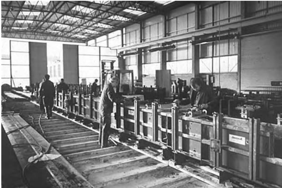
Εικ. 1.3: Παραγωγή προκατασκευασμένων κατασκευαστικών μελών από σκυρόδεμα σε μεταλλότυπους. (Πηγή: “PRECAST CONCRETE STRUCTURES”, Kim S. Eliot)
