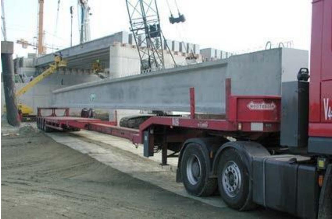
Εικ. 4.12: Δοκός τύπου I κατά την ανύψωσή της. (Πηγή: “PRECAST CONCRETE BRIDGES”, state-of-art-report, fib ceb-fip (bulletin 29))
