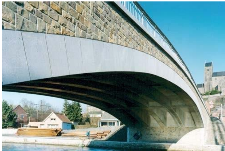
Εικ. 4.37: Προκατασκευασμένη γέφυρα με καμπύλες δοκούς. Η κατασκευή των ακροβάθρων έλαβε χώρα επί τόπου με λιθοδομή και υποστηρίζεται από την αναχίλωση στο κάτω μέρος της προκατασκευασμένης δοκού. (Πηγή: “PRECAST CONCRETE BRIDGES”, state-of-art-report, fib ceb-fip (bulletin 29))
