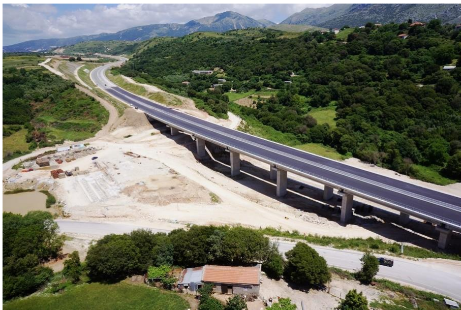
Εικ. 7.4: Η γέφυρα Γυμνότοπου μετά την περάτωση των εργασιών κατασκευής του φορέα. (Πηγή: “Αετός των Τζουμέρκων”, www.voreini.gr )
