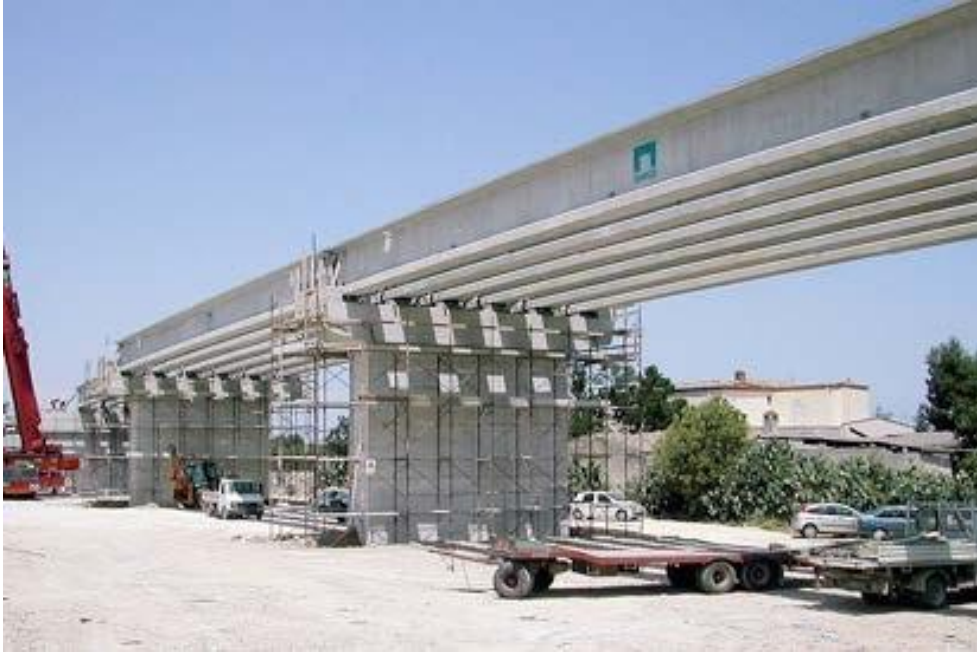
Εικ. 4.8: Γέφυρα αυτοκινητοδρόμου υπό κατασκευή με προκατασκευασμένες δοκούς. (Πηγή: “PRECAST CONCRETE BRIDGES”, state-of-art-report, fib ceb-fip (bulletin 29))
