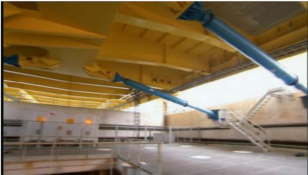
Εικόνα 40: Σύνδεση καταστρώματος και πυλώνων με αποσβεστήρες
