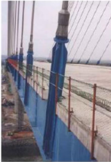
Εικόνα 35: Αγκυρώσεις καλωδίων επί του καταστρώματος
