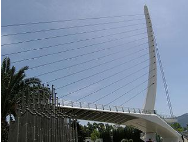
Εικόνα 13: Πεζογέφυρα στην Α.Κατεχάκη
