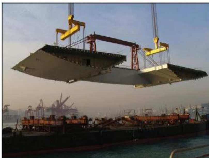
Εικόνα 38: Μεταλλικό κατάστρωμα καλωδιωτής γέφυρας
