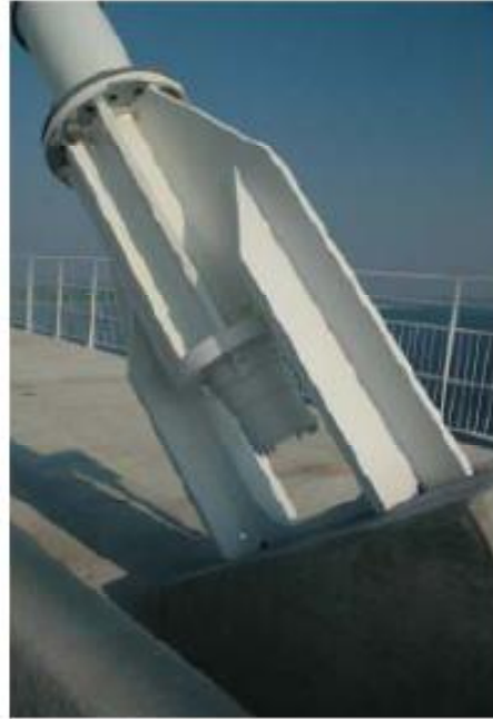
Εικόνα 35: Αγκυρώσεις καλωδίων επί του καταστρώματος
