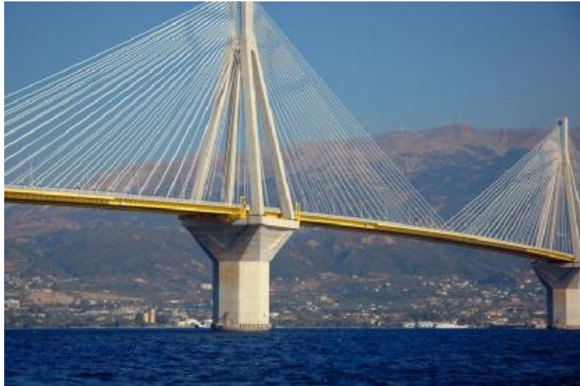
Εικόνα 28: Πυλώνας γέφυρας Ρίου-Αντιρρίου
