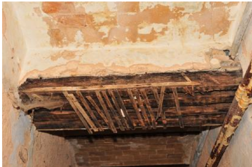
Εικόνα 26. Δοκάρια οροφής ισογείου Πηγή: Προσωπική λήψη
