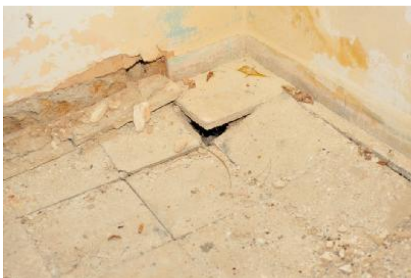
Εικόνα 10. Ισόγειο, σημείο καθίζησης, Δωμάτιο Π Πηγή: Προσωπική λήψη
