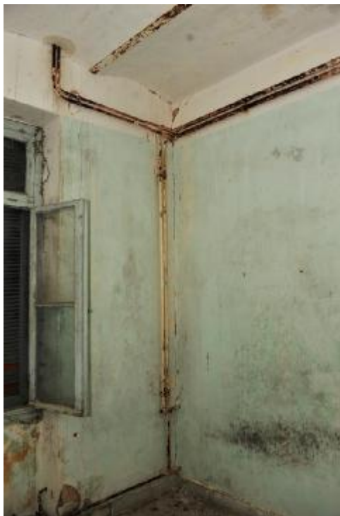
Εικόνα 23. Λεπτομέρεια Χρωματισμού και υδραυλικών εγκαταστάσεων θέρμανσης Πηγή: Προσωπική λήψη
