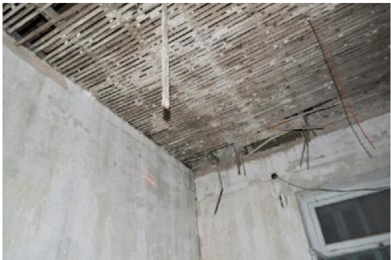
Εικόνα 35. Ψευδοροφή ορόφου από μπαγδατί. Χώρος Ο.01 Πηγή: Προσωπική λήψη
