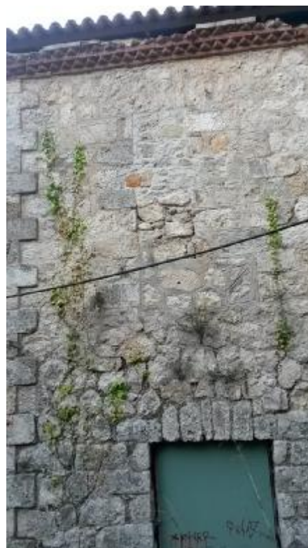
Εικόνα 18. Λεπτομέρεια Βόρειας Όψης / σφραγισμένο παραθυρο με προσθηκη λιθοδομής Πηγή: Προσωπική λήψη
