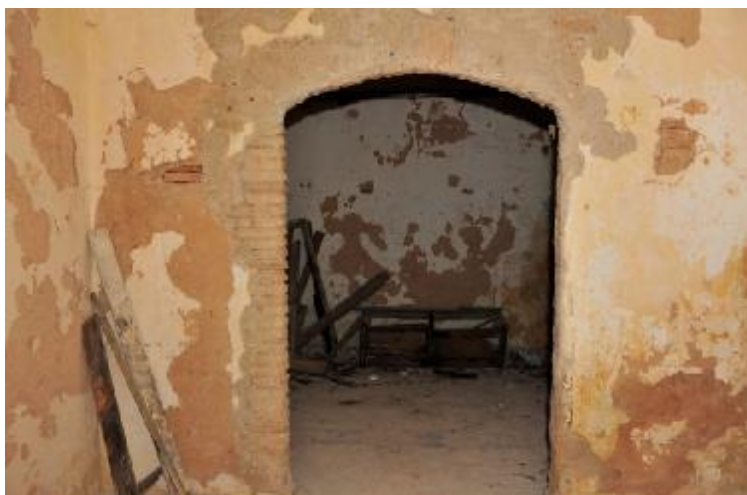
Εικόνα 12. Εσωτερική φέρουσα τοιχοποιία με τοξωτό πρέκι Πηγή: Προσωπική λήψη
