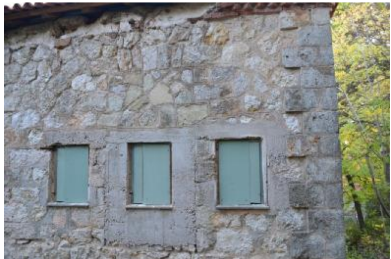
Εικόνα 17. Λεπτομέρεια Βόρειας Όψης / αλλαγή χρήσης και όψης Πηγή: Προσωπική λήψη
