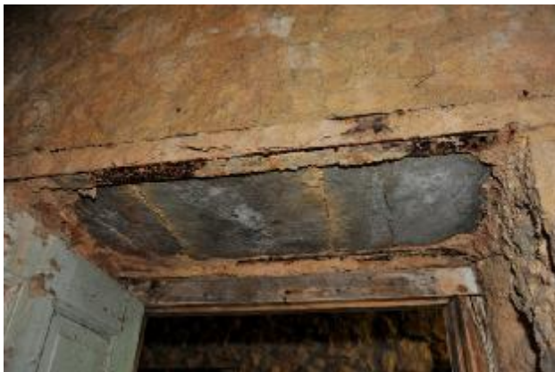
Εικόνα 15. Λεπτομέρεια μεταλλικής δοκού διπλού ταν με γεφύρωση από σχιστόπλακες Πηγή: Προσωπική λήψη
