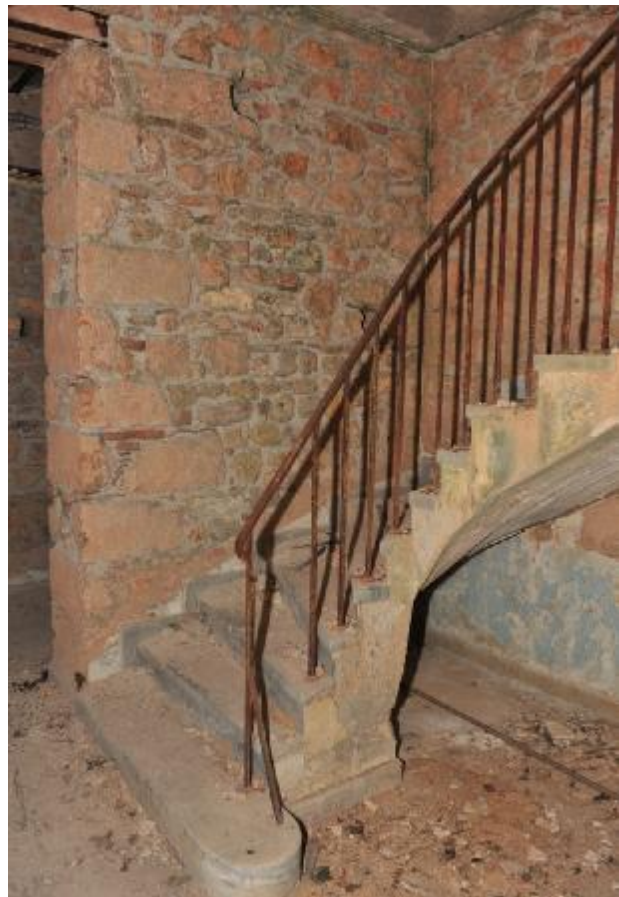
Εικόνα 36. Εσωτερική κλίμακα και λίθινος τοίχος Πηγή: Προσωπική λήψη
