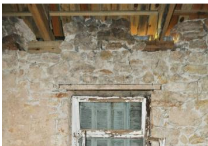
Εικόνα 32. Σημείο σύνδεσης στέψης τοίχου – στέγης Πηγή: Προσωπική λήψη
