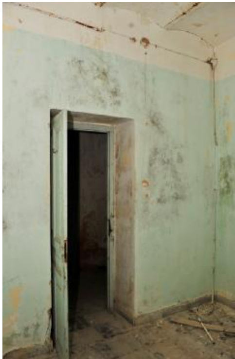
Εικόνα 22. Λεπτομέρεια Χρωματισμού και ηλεκτρολογικών εγκαταστάσεων Πηγή: Προσωπική λήψη
