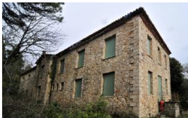
Εικόνα 3. Άποψη από την Νοτιοδυτική γωνία του κτίσματος Πηγή: Προδωπική λήψη
