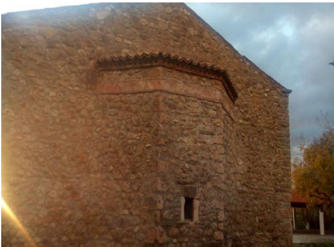
Απεικονίζεται το παράθυρο και η διακοσμητική ζώνη η οποία είναι κατασκευασμένη από τριγωνικές οπτόπλινθους.
