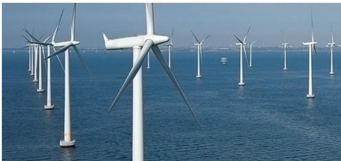
Εικόνα 4.2.3: Υπεράκτιο αιολικό πάρκο
