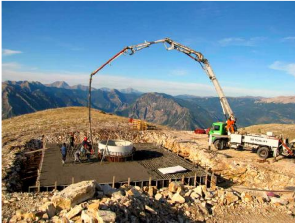
Εικόνα 3.3.8: Τοποθέτηση σκυροδέματος για τη δημιουργία της βάσης
