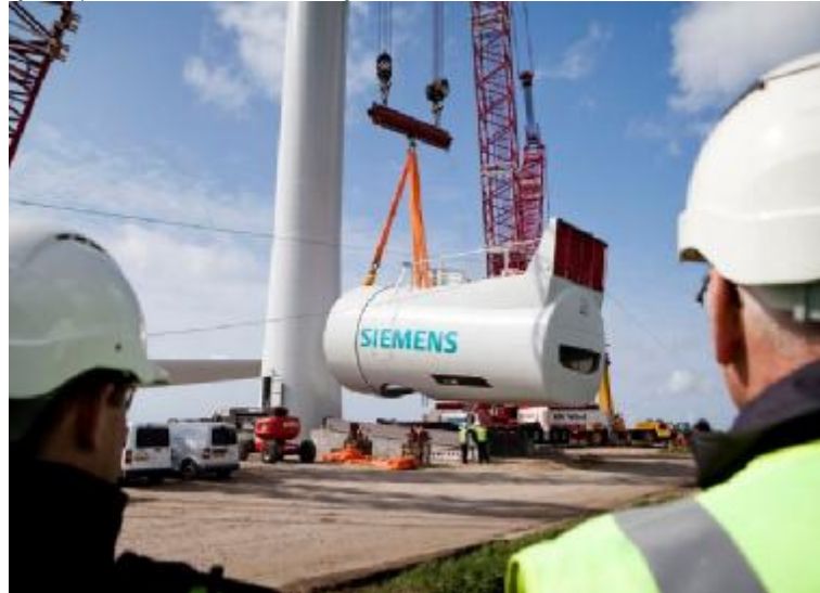
Εικόνα 3.3.3: Άτρακτος ανεμογεννήτριας
