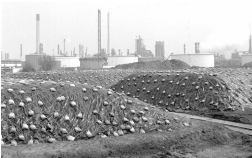
Σχήμα 4.6: Βιοεξυγίανση εδαφών ρυπασμένων με πετρελαιοειδή με τη μέθοδο επεξεργασίας με σωρούς εξοπλισμένοι με σύστημα απομάκρυνσης αερίων.
