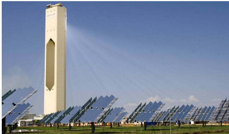
Εικόνα 17: Ηλιακός Πύργος Ισχύος [Πηγή: Αραπόγλου, 2016]
