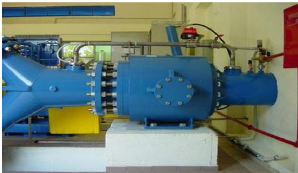
Εικόνα 13: Σφαιρική δικλείδα εισόδου.
