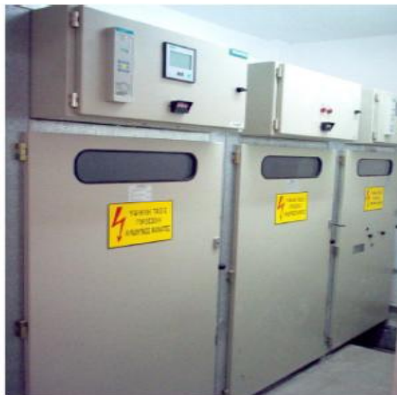
Εικόνα 16: Μετασχηματιστής - Πίνακες αυτόματου ελέγχου.
