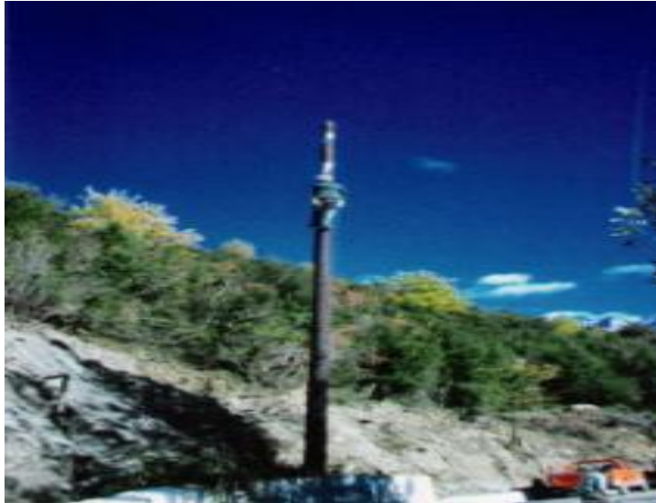
Εικόνα 17: Κατασκευή δικτύου Μ.Τ από τη ΔΕΗ.
