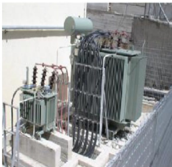
Εικόνα 16: Μετασχηματιστής - Πίνακες αυτόματου ελέγχου.
