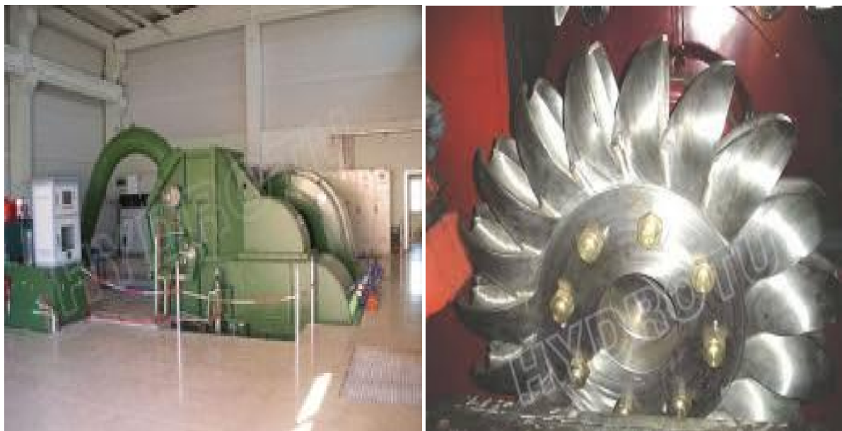
Εικόνα 2: Στρόβιλος Pelton με τα χαρακτηριστικά του.
