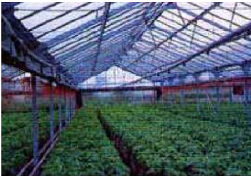
Εικόνα 1: Μεταλλική κατασκευή πρότυπου θερμοκηπίου.
