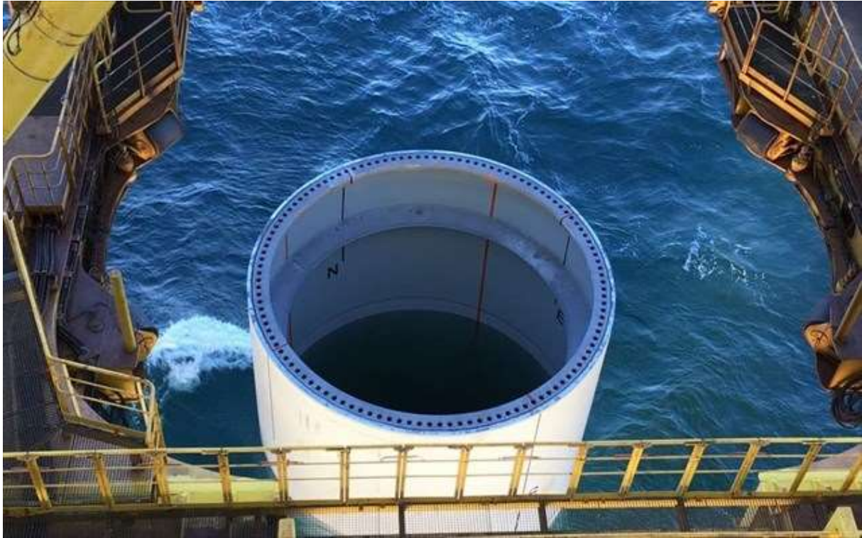
Εικόνα 49:Κυλινδρική κατασκευή στήριξης
