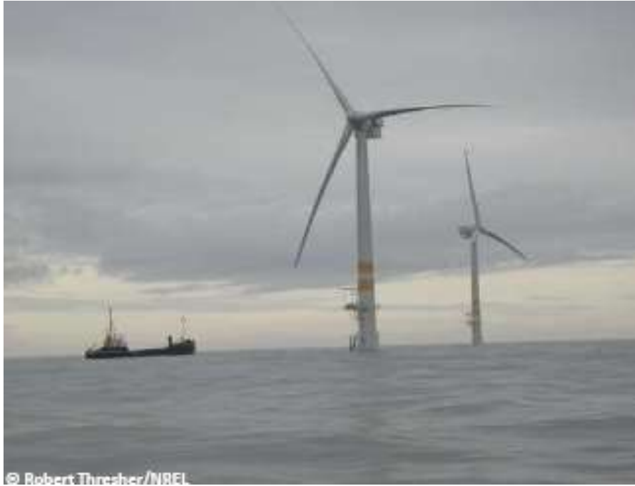
Εικόνα 13: Αιολικό πάρκο μέσα στη θάλασσα
