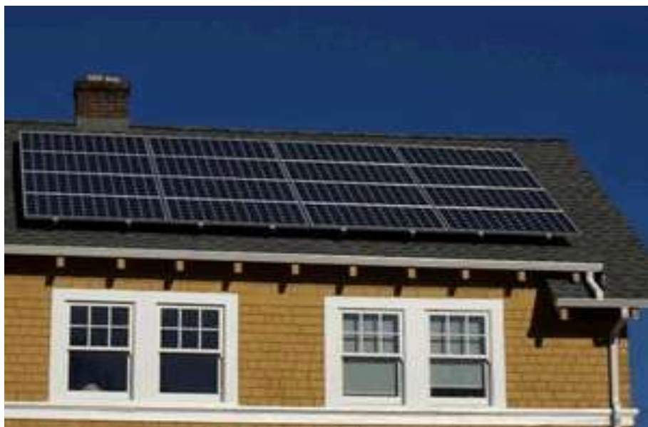
Εικόνα 22:Εγκατάσταση ΦΒ σε στέγη
