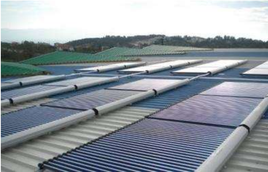
Εικόνα 43: Η στέγη του κολυμβητηρίου Πανοράματος
