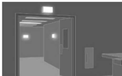
Εικόνα 57: Έκτακτης ανάγκης και ασφαλείας φωτισμός
