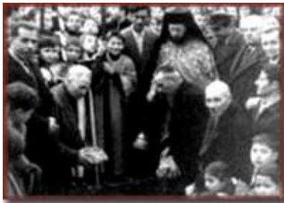
Εικόνα 4 Θεμελίωση Ιερού Ναού Αγίου Γεωργίου Κορυδαλλού (1945)
