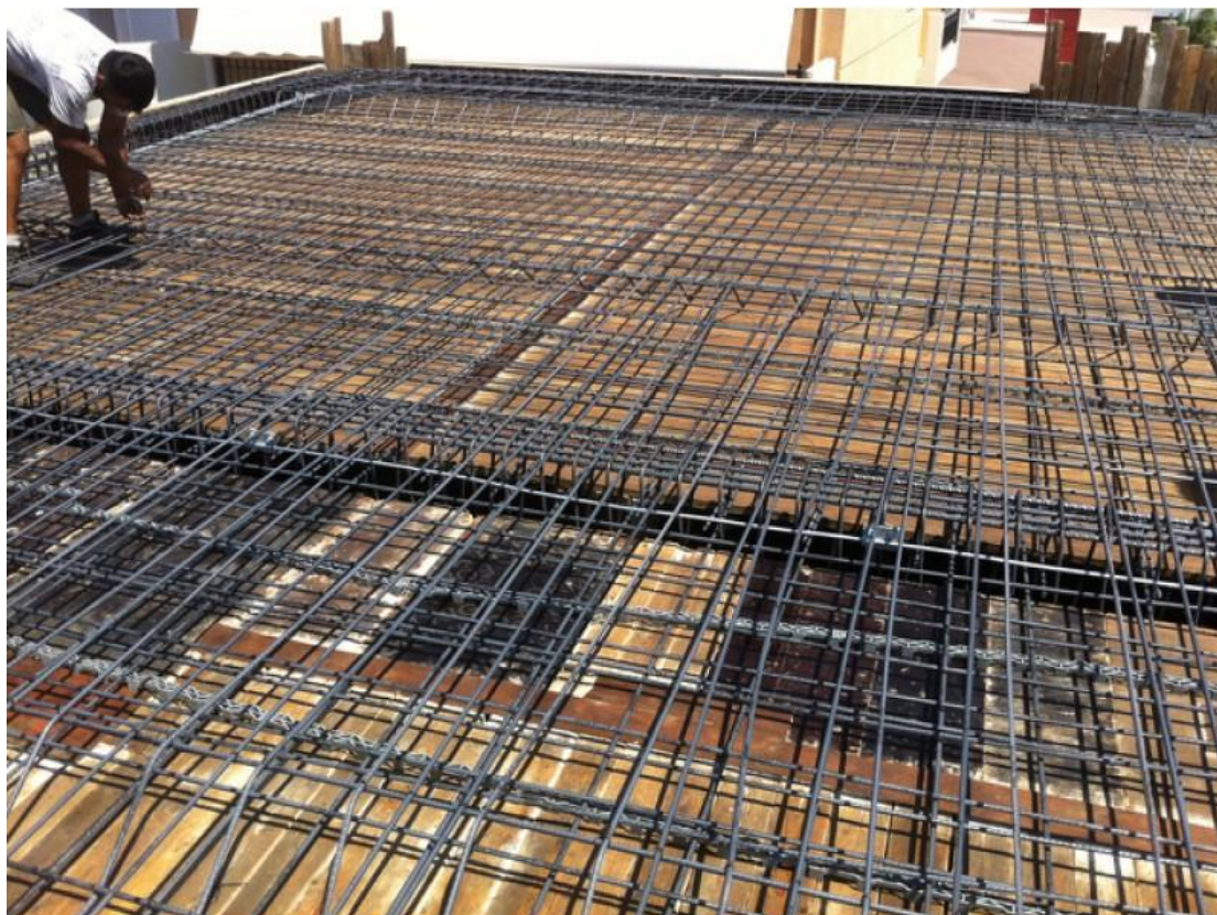
Εικόνα 33: Κατασκευή θεμελιακής γείωσης
