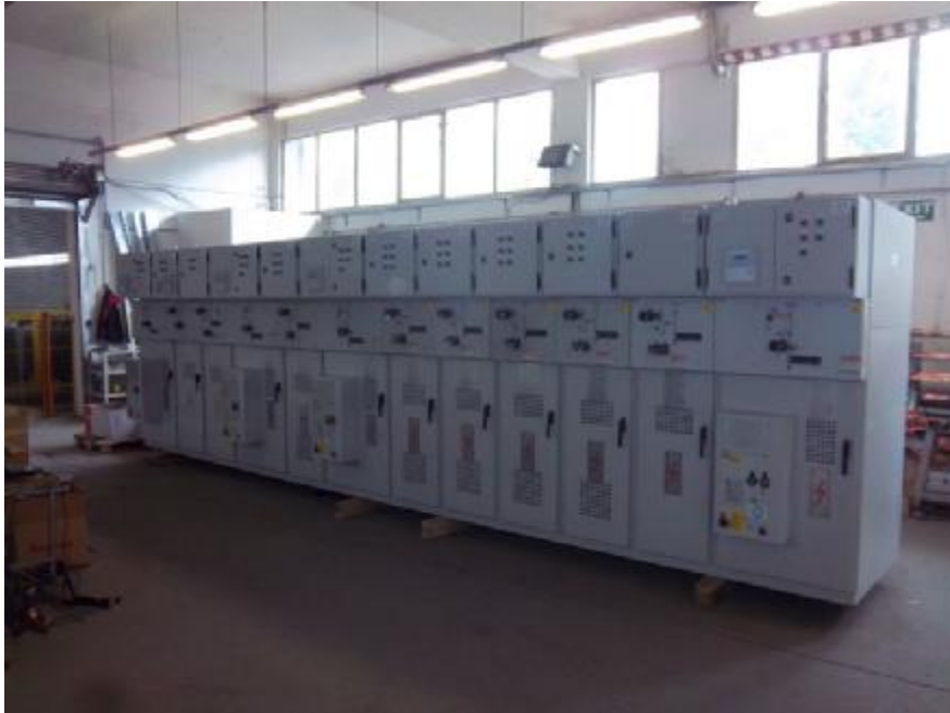
Εικόνα 18: Πεδία Χ.Τ. σε υποσταθμό
