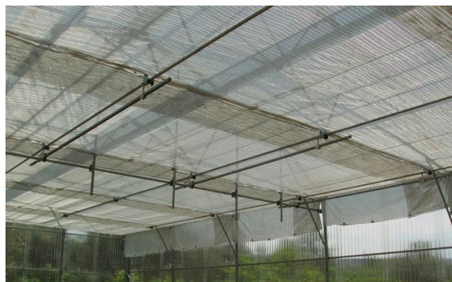
Σχήμα 2.10: Παράδειγμα θερμοκουρτίνας με μηχανισμό κίνησης (Πηγή: http://geotherm.gr )
