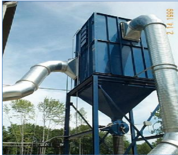
Εικόνα 3.1: Γενική εικόνα σακόφιλτρου.
