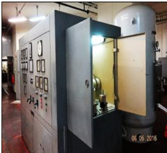
Εικόνα 6: Ρυθμιστής στροφών, εξωτερικά οι ενδείξεις, εσωτερικά ο μηχανισμός.(πηγή: ΔΕΗ Α.Ε)
