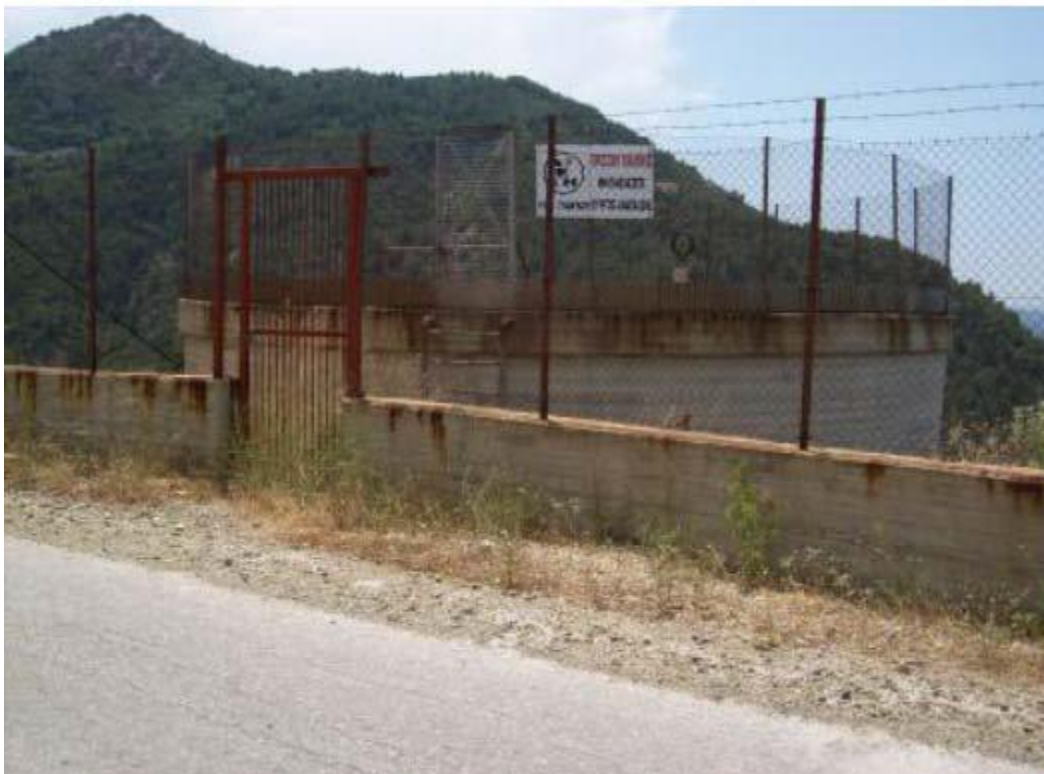
Εικόνα 14: Υδατόπυργος φράγματος Γλαύκου.
