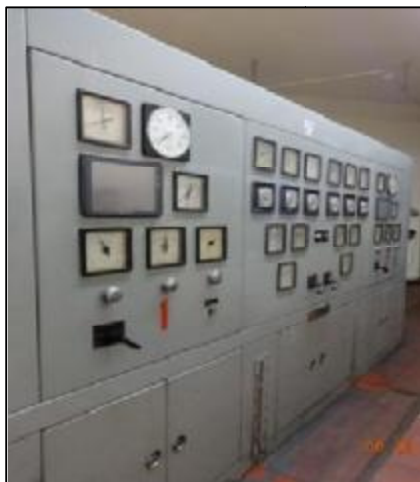
Εικόνα 7: Ταμπλό ρυθμιστή στροφών αριστερά, θάλαμος ελαίου ψύξης δεξιά. (πηγή: ΔΕΗ Α.Ε)
