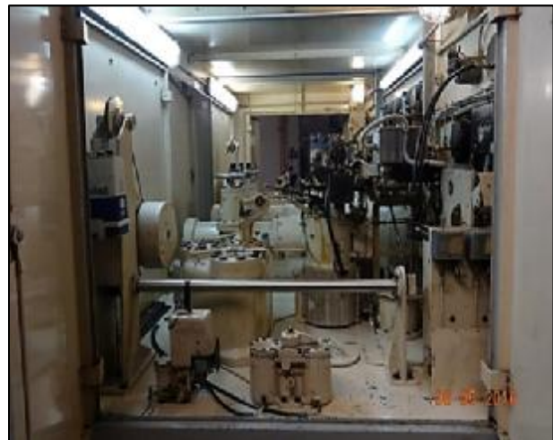
Εικόνα 6: Ρυθμιστής στροφών, εξωτερικά οι ενδείξεις, εσωτερικά ο μηχανισμός.(πηγή: ΔΕΗ Α.Ε)
