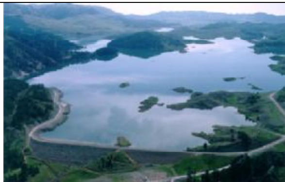
Εικόνα 3: Το φράγμα και ο ταμιευτήρας του ΥΗΣ Αώου.
