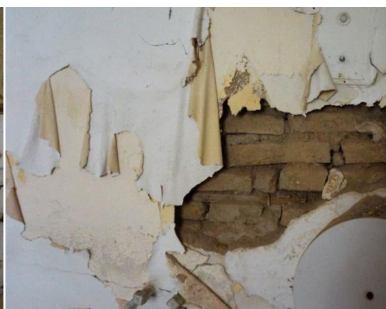
Εικόνα 45. Αποκόλληση επιχρισμάτων
