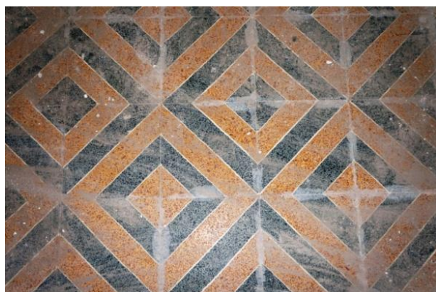
Εικόνα 36 Τσιμεντοπλακίδια
