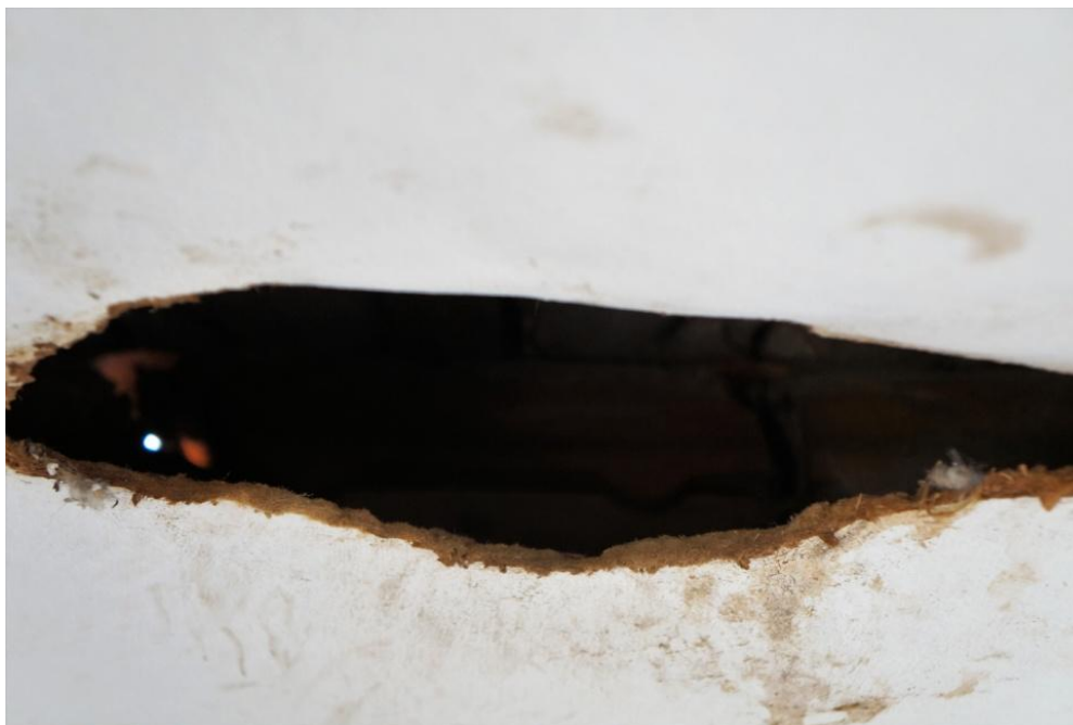
Εικόνα 72. Φούσκωμα μοριοσανίδας
