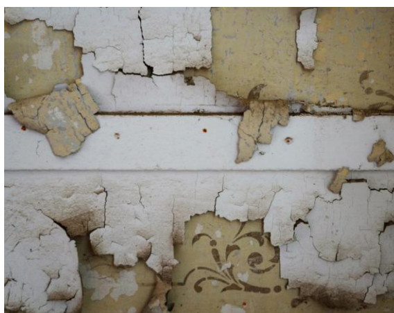
Εικόνα 44. Ξεφλούδισμα χρώματος
