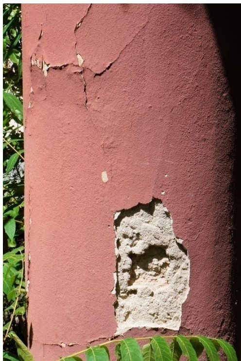
Εικόνα 43. Αποκόλληση επιχρισμάτων
