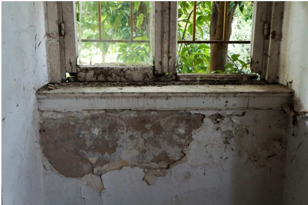
Εικόνα 49. Ανερχόμενη υγρασία
