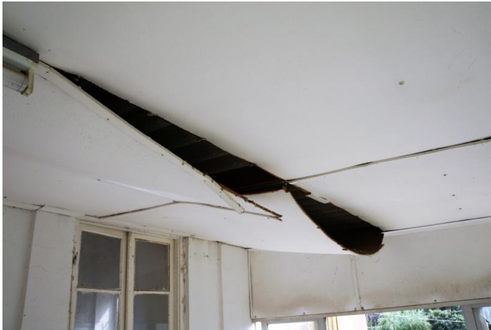
Εικόνα 71. Οροφή πρώτου ορόφου
