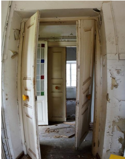
Εικόνα 61. Διαβρωμένα κουφώματα
