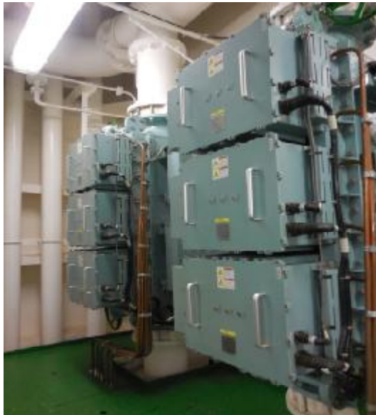
( Εικόνα 4.5: μονάδες ECU σε παράλληλη σύνδεση )
