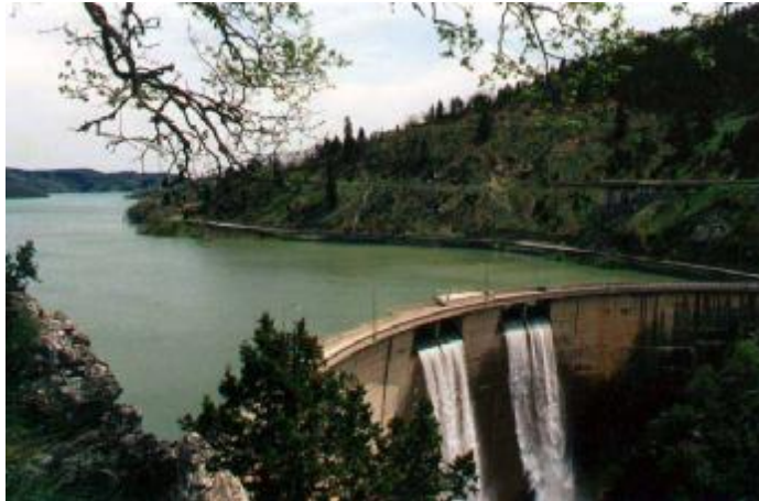
[Εικόνα 1.4.(5)Υδροηλεκτρικός Σταθμός Ν. Πλαστήρα(9)
