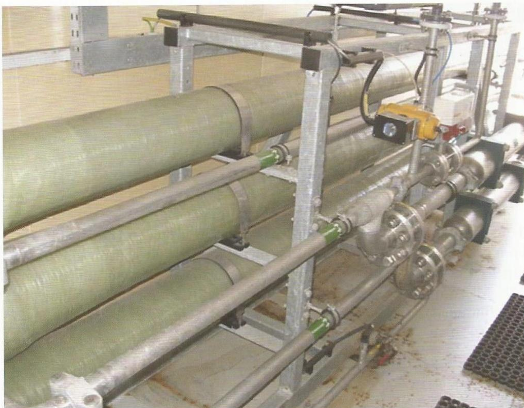
Εικόνα 2.10 Μεμβράνες αντίστροφης ώσμωσης σε κοντέινερ για την επεξεργασία στραγγισμάτων στον ΧΥΤΑ Κατερίνης [5]
