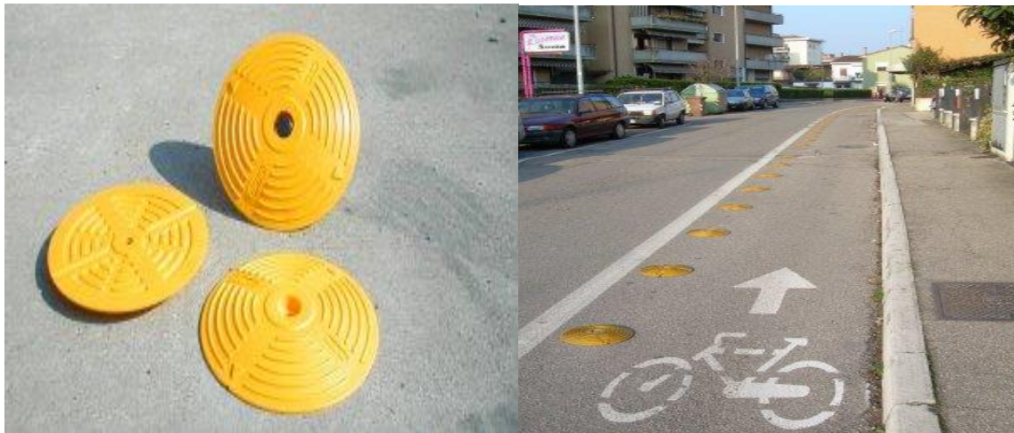
Εικόνα 27. Διαχωριστής λωρίδων από πολυουρεθάνιο. (3 η περίπτωση)
