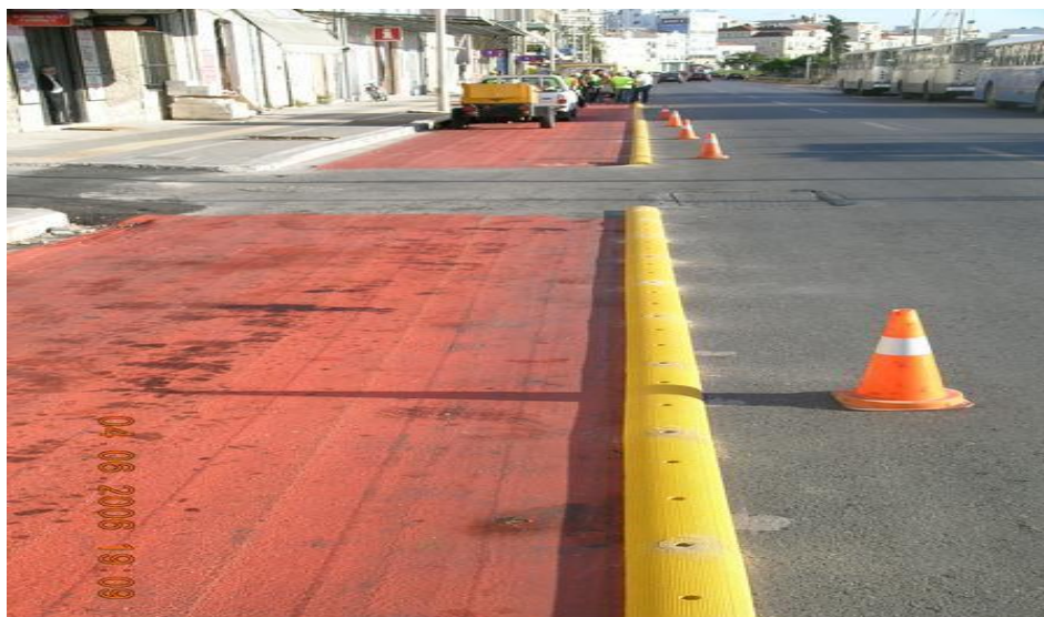
Εικονα 25. Διαχωριστής λωρίδων από πολυουρεθάνιο. (1 η περίπτωση)
