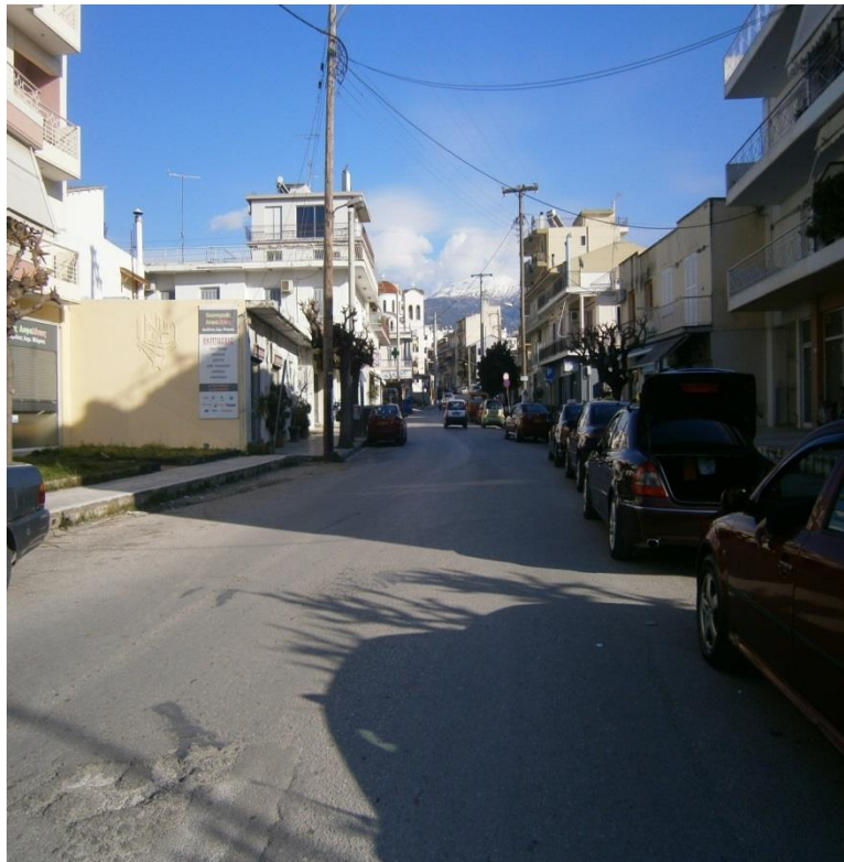
Εικόνα 151. Αφεταιρία της οδού Αγ. Κωνσταντίνου
