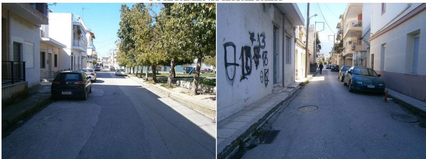
Εικόνα 101. Αφετηρία της οδού Ιουλιανού (αριστερά) τέλος της οδού(δεξιά)
