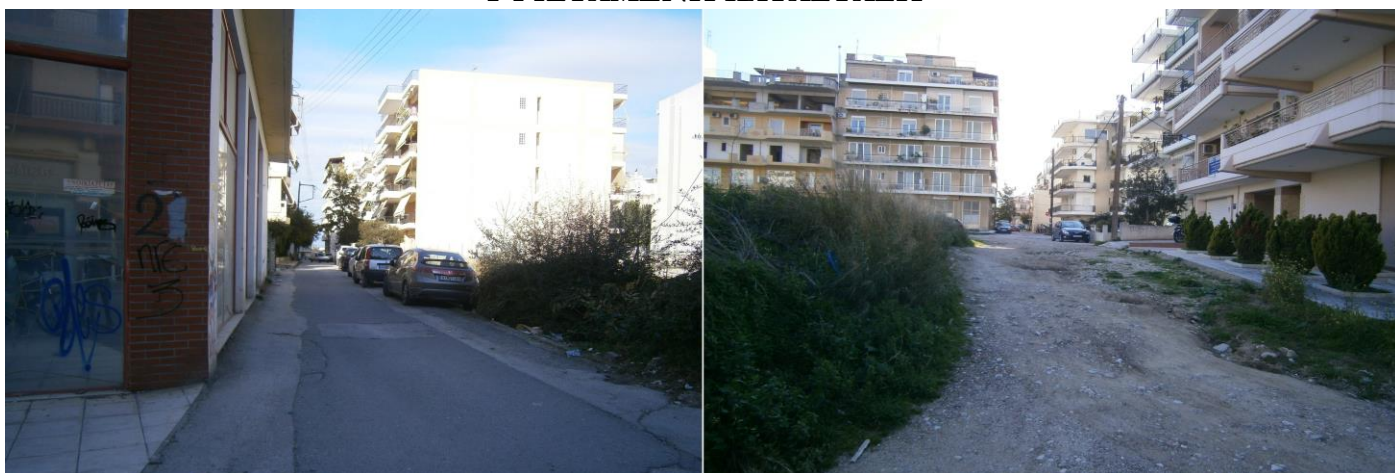
Εικόνα 153. Αφετηρία της οδού Αξιού(αριστερά) τέλος της οδού(δεξιά )
