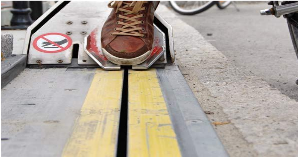
Εικόνα 49. Σύστημα κυλιόμενου ανυψωτήρα για ποδήλατα «CycloCable».
