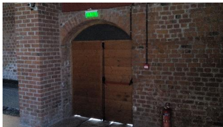
Εικόνα 95-96: Το φωτιστικό εκτάκτου ανάγκης, τοποθετημένο ακριβώς πάνω από την έξοδο.
