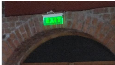
Εικόνα 95-96: Το φωτιστικό εκτάκτου ανάγκης, τοποθετημένο ακριβώς πάνω από την έξοδο.
