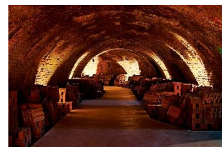
Εικόνα 41: Εσωτερική άποψη του καμίνου Χόφμαν.
