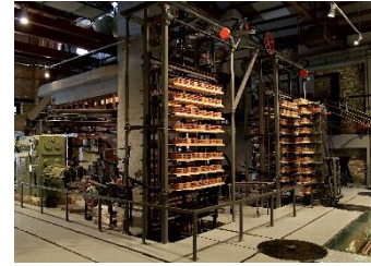
Εικόνα 44: Άποψη της κεντρικής μονάδας παραγωγής.
