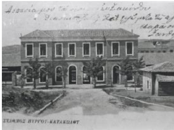
Εικόνα 60. Ο Σταθμός του Σιδηρόδρομου Πύργου- Κατάκολου, δεκαετία 1900.
