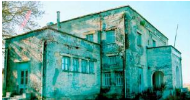
Εικόνα 17. Το κτίριο το 2006.
