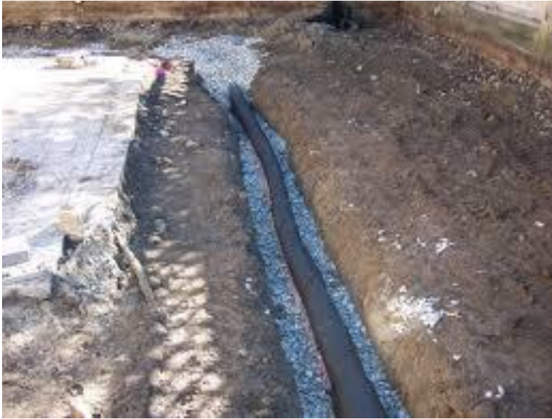
Εικόνα 3.1.7. Περιοχή εκσκαφής αγωγού.
