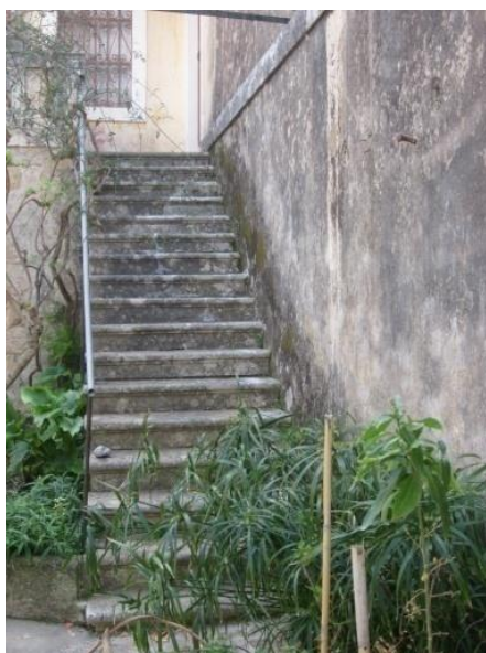
Εικόνα 2.2.4. Εξωτερική σκάλα. Δυτική πλευρά
