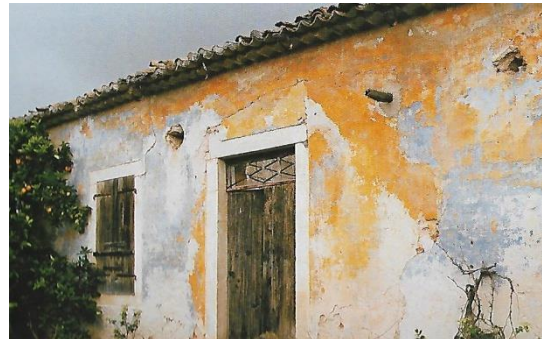
Εικόνα 1.40. Οικία Βαλεντή. Διακρίνονται τα αλλεπάλληλα στρώματα με διαφορετικό χρώμα.
