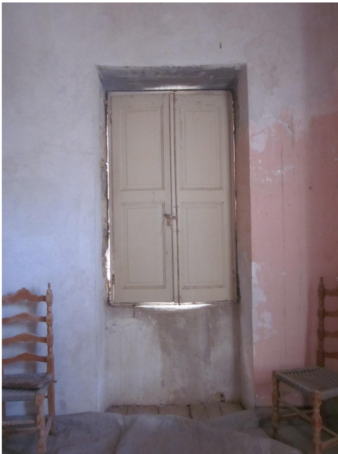
Εικόνα 3.1.3. Αποτελέσματα υγρασίας εσωτερικά.
