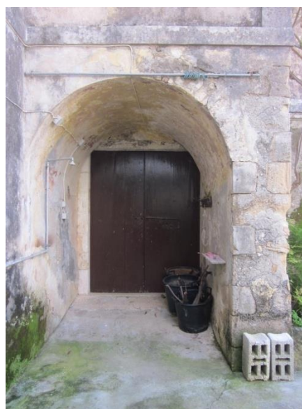
Εικόνα 2.2.5 Πλάγια πόρτα- 'πίσω πόρτα'. Δυτική πλευρά.
