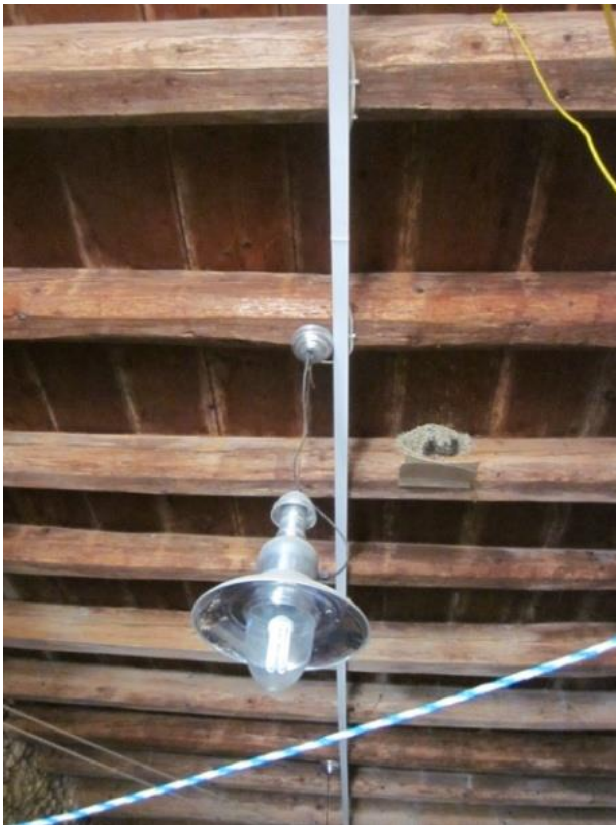
Εικόνα 3.1.3.2. Ξύλινη οροφή ισογείου.
