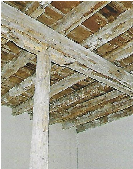
Εικόνα 1.14. Δάπεδο πρώτου ορόφου όπως φαίνεται από το ισόγειο.
