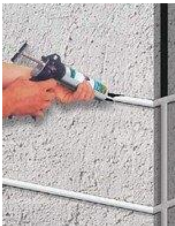
Εικόνα 3.1.5. Διείσδυση υγρομονωτικής ρητίνης.
