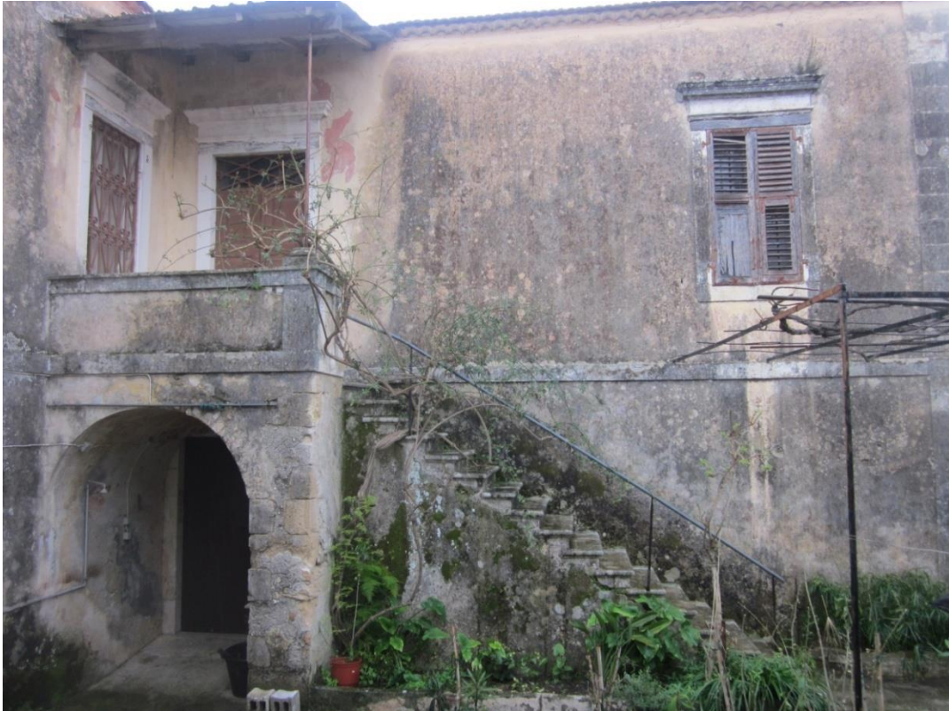
Εικόνα 4.1.7. Βόρειο – Δυτική πλευρά.
