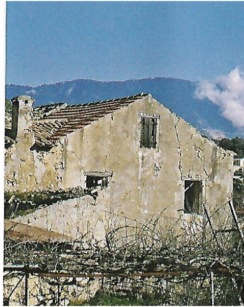
Εικόνα 1.23. Στέγη με εισαγόμενα κόκκινα γαλλικά κεραμίδια. Σβορωνάτα Λειβαθούς.
