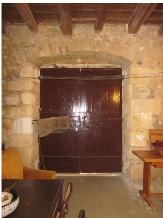
Εικόνα 2.2.10 Πλάγια πόρτα – ‘πίσω πόρτα’. Δυτικής πλευράς.
