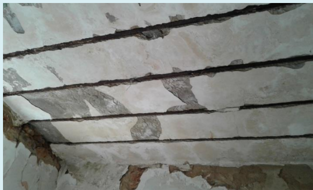
Εικ. 27 Ταβάνωμα με εμφανής σιδηροδοκούς
