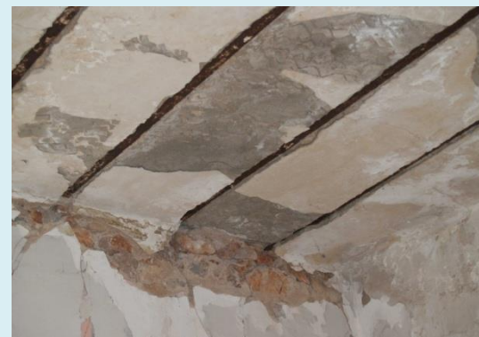
Εικ. 28 Ταβάνωμα με εμφανής σιδηροδοκούς
