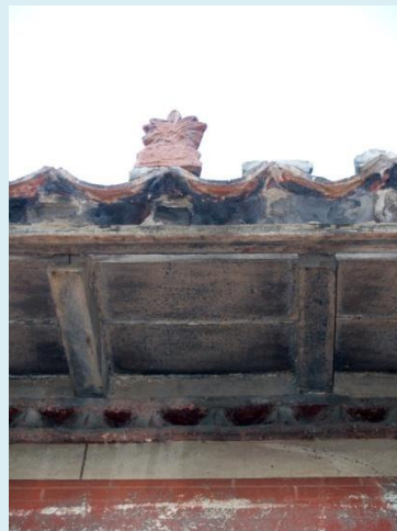
Εικ. 24 Εμφανής αμείβοντες και ακροκέραμο
