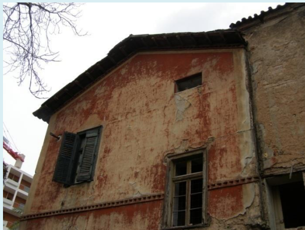
Εικ. 23 Βόρεια όψη- άποψη στέγης
