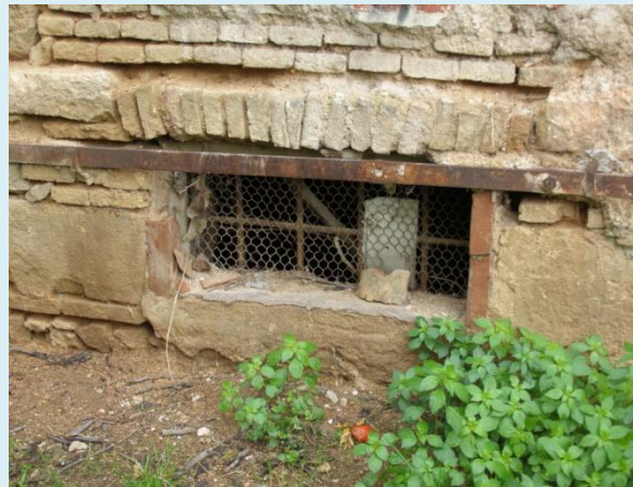
Εικ. 20, 21, 22 Οπτοπλινθοδομή και λιθοδομή στις όψεις του κτιρίου
