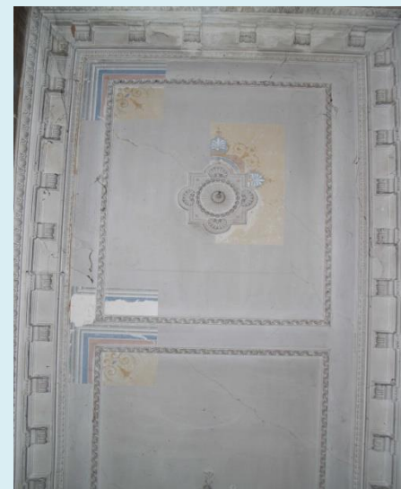
Εικ. 16 Οροφografia καλυμμένη με επίχρισμα
