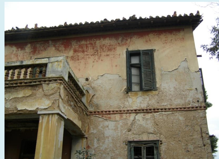
Εικ. 25 Πρόσοψη - Ακροκέραμα στη στέγη
