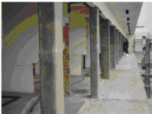
Εικόνα 49:Ενίσχυση υποστηλωμάτων
