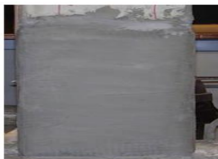
Εικόνα 27: Τελική Επίστρωση με Τσιμεντοκονία
