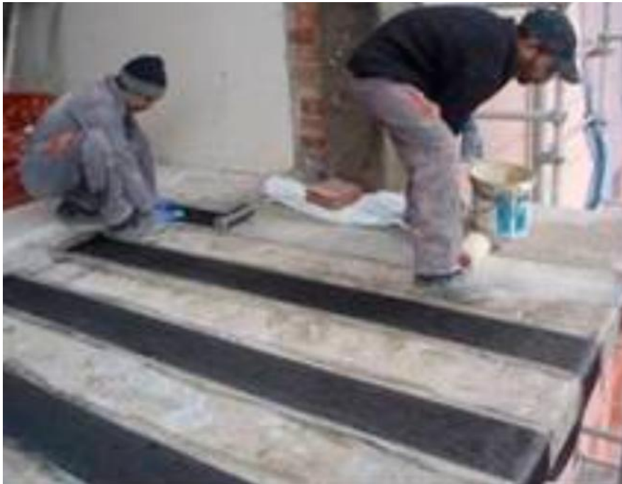
Εικόνα 39: Ενίσχυση προβόλου με υφάσματα ινών
