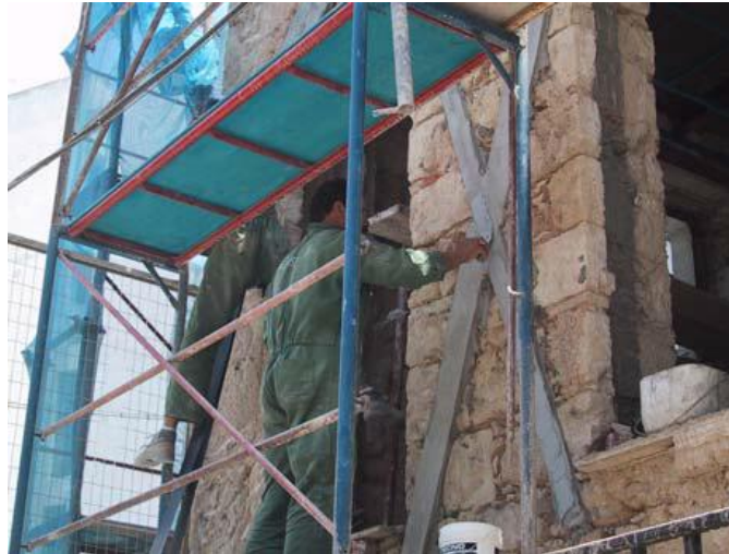
Εικόνα 57: Ενίσχυση σχολείου από φέρουσα λιθοδομή
