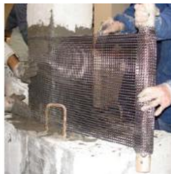
Εικόνα 26: Περιτύλιξη πλέγματος
