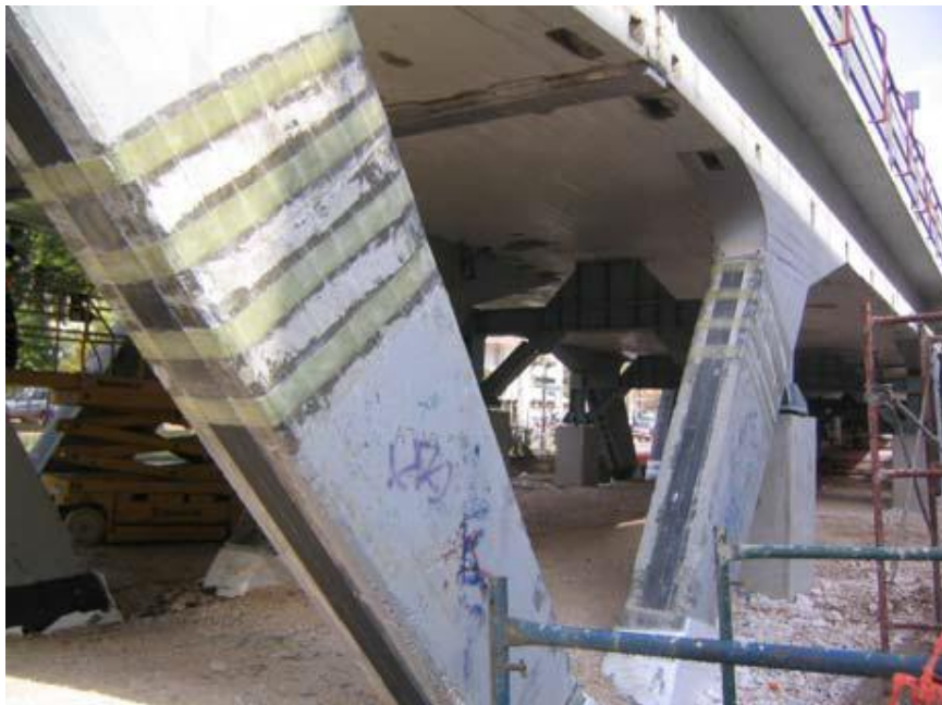
Εικόνα 53: Γέφυρα σιδηροδρομικού σταθμού, Μαρούσι
