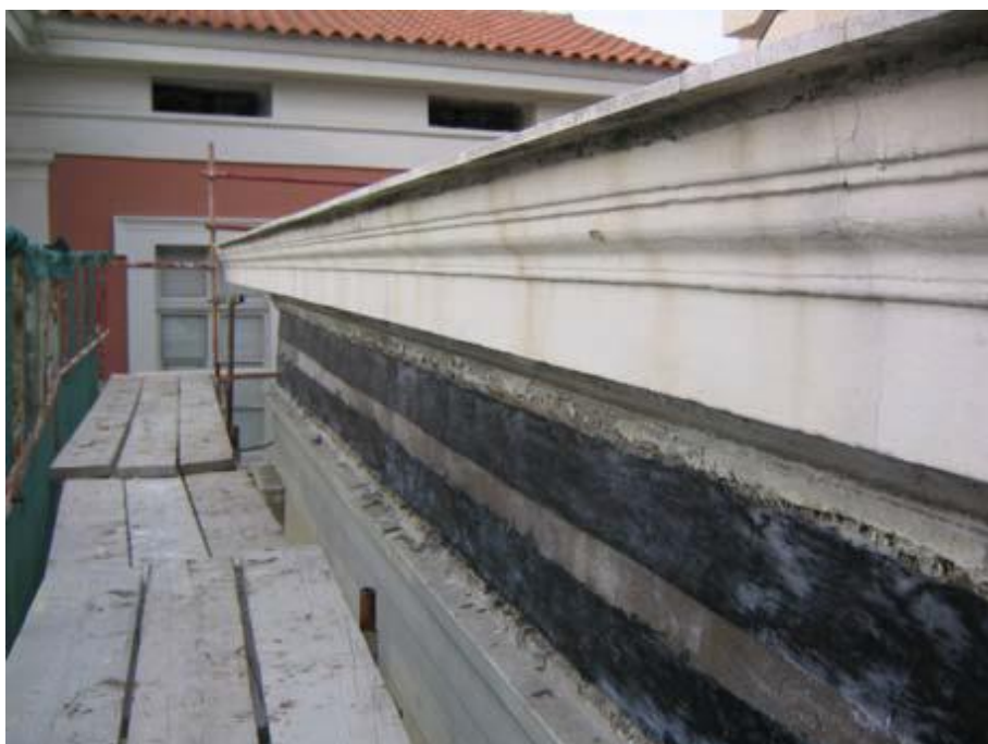
Εικόνα 56: Ενίσχυση κτιρίου νομικής σχολής Αθηνών
