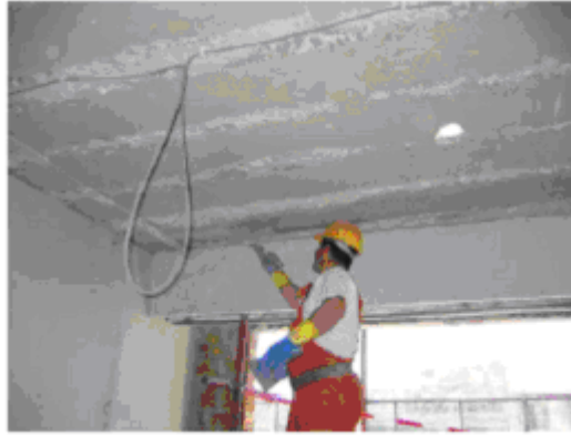
Εικόνα 47:Εφαρμογή πυροπροστασίας
