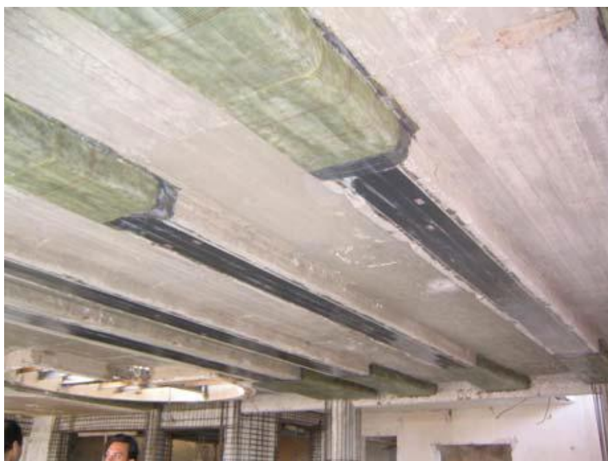
Εικόνα 51: Μαρίνα Ζέας, ενίσχυση πλακοδοκών
