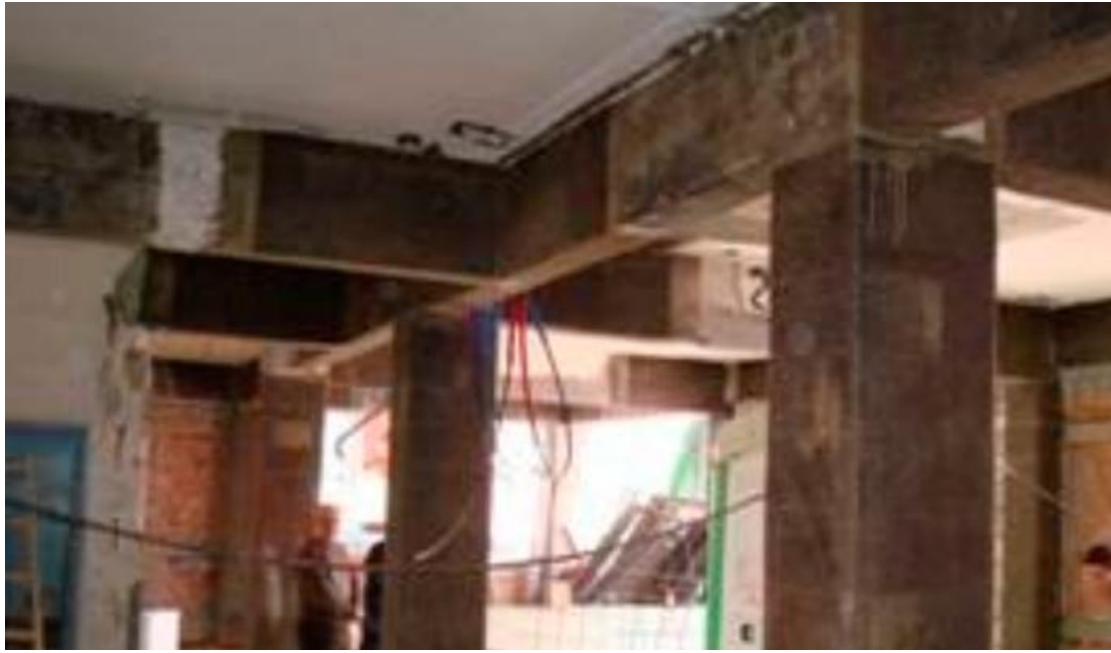
Εικόνα 38: Ενίσχυση υποστυλωμάτων, δοκών και κόμβων με υφάσματα σύνθετων υλικών
