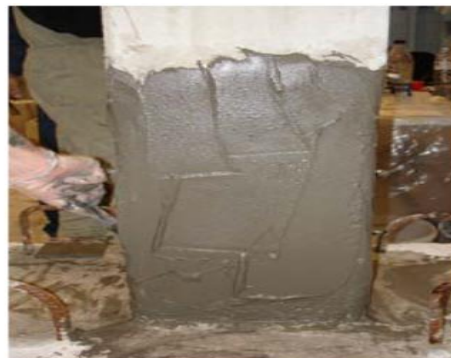
Εικόνα 25:Επάλειψη επιφάνειας με κονίαμα
