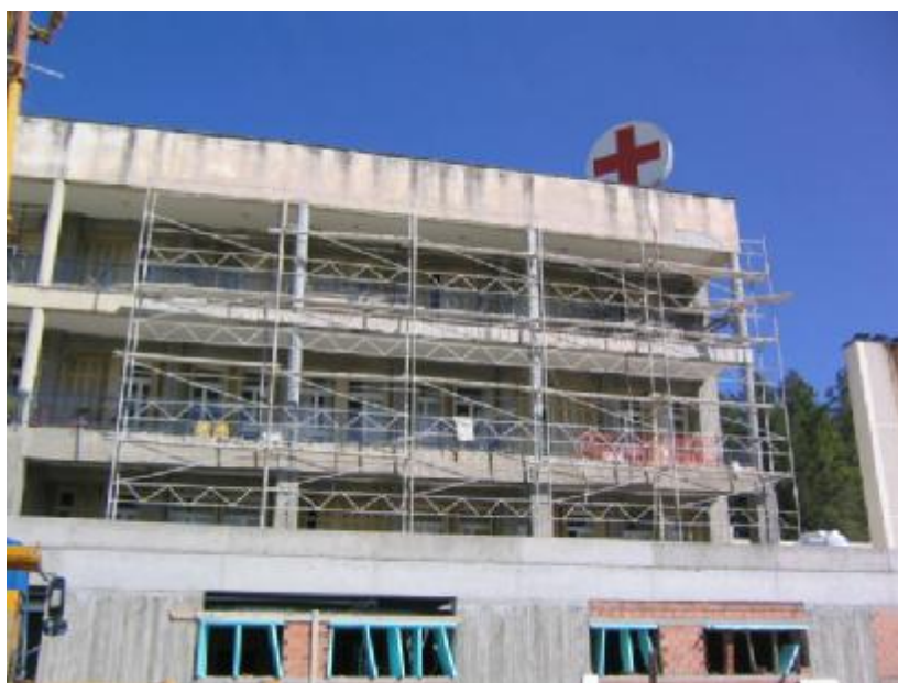
Εικόνα 45: Ενίσχυση των κυκλικών υποστυλωμάτων του γενικού νοσοκομείου της Σπάρτης
