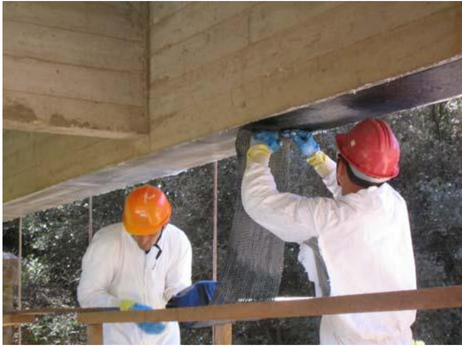
Εικόνα 54: Γέφυρα στον Εύηνο ποταμό
